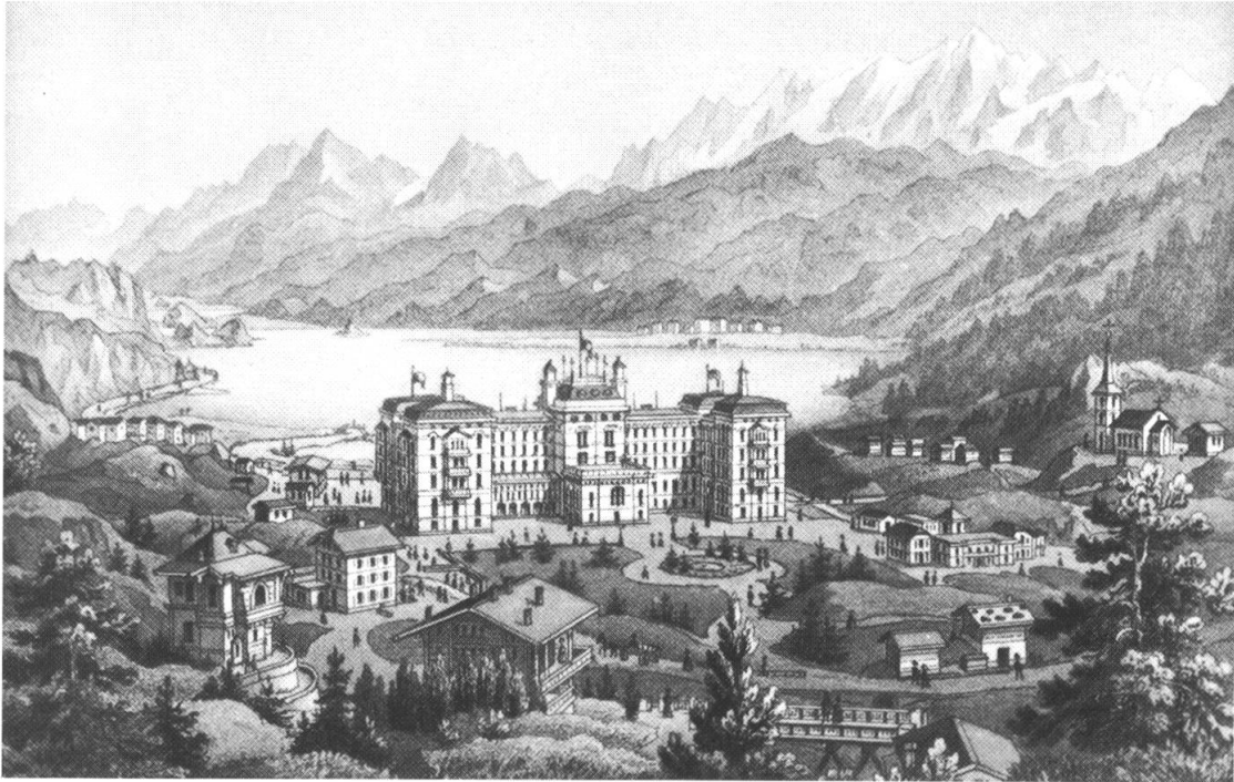
Abb. 7. Die Umgebung des Hotels Maloja-Palace um die Mitte der 1880er Jahre mit der Parkanlage und den «Breitestrassen». Stahlstich von J. R. Dikenmann. (Foto Rätisches Museum Chur)
