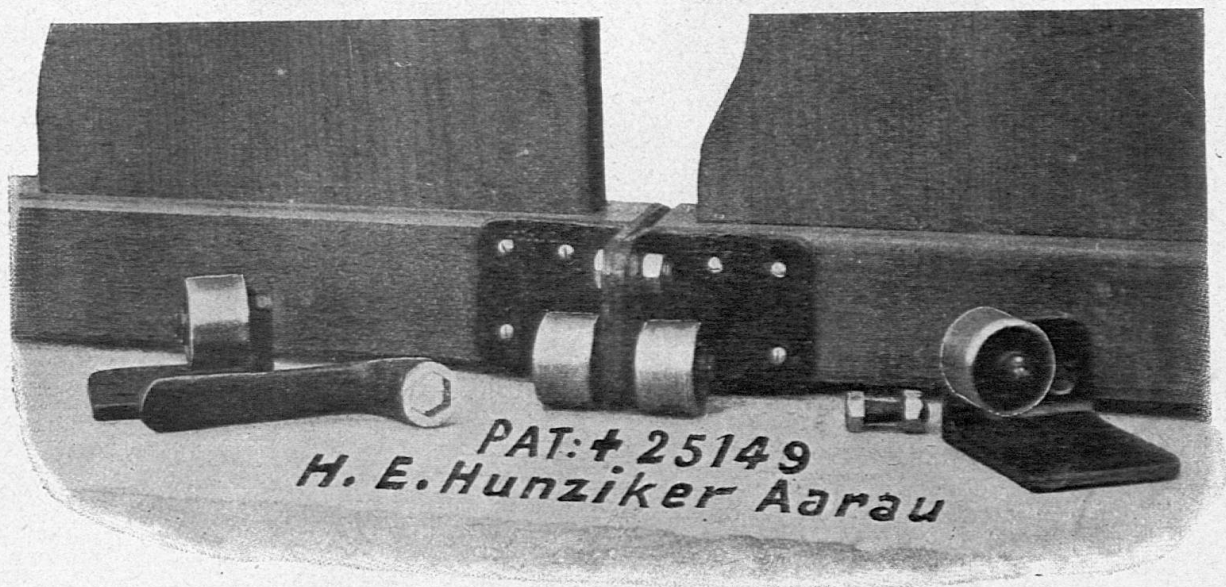
Fig. 6. Rollenkuppelung von H. E. Hunziker in Aarau.
