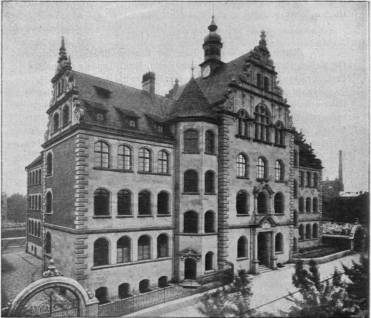
Nürnberg. Schulhaus Labenwolfstrasse. Ansicht.
