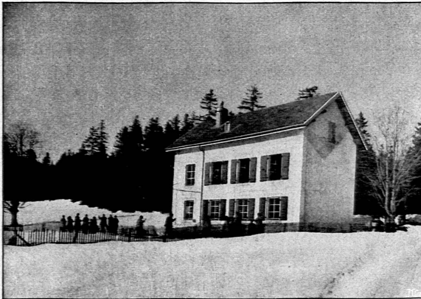
La maison d'école du Mont de Boveresse, construite en 1893. Paysage d'hiver.
