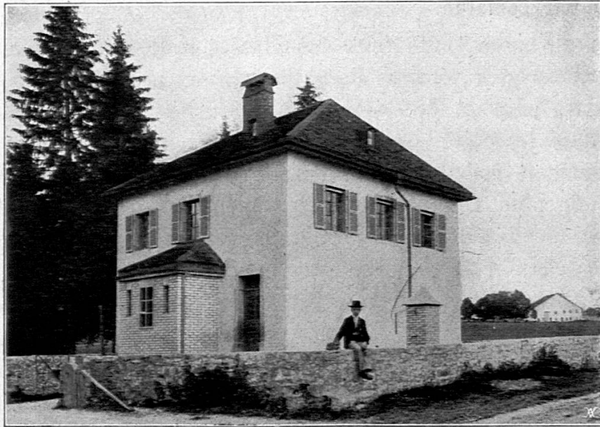
La maison d'école du Valanvron (La Chaux-de-Fonds), construite en 1851.
