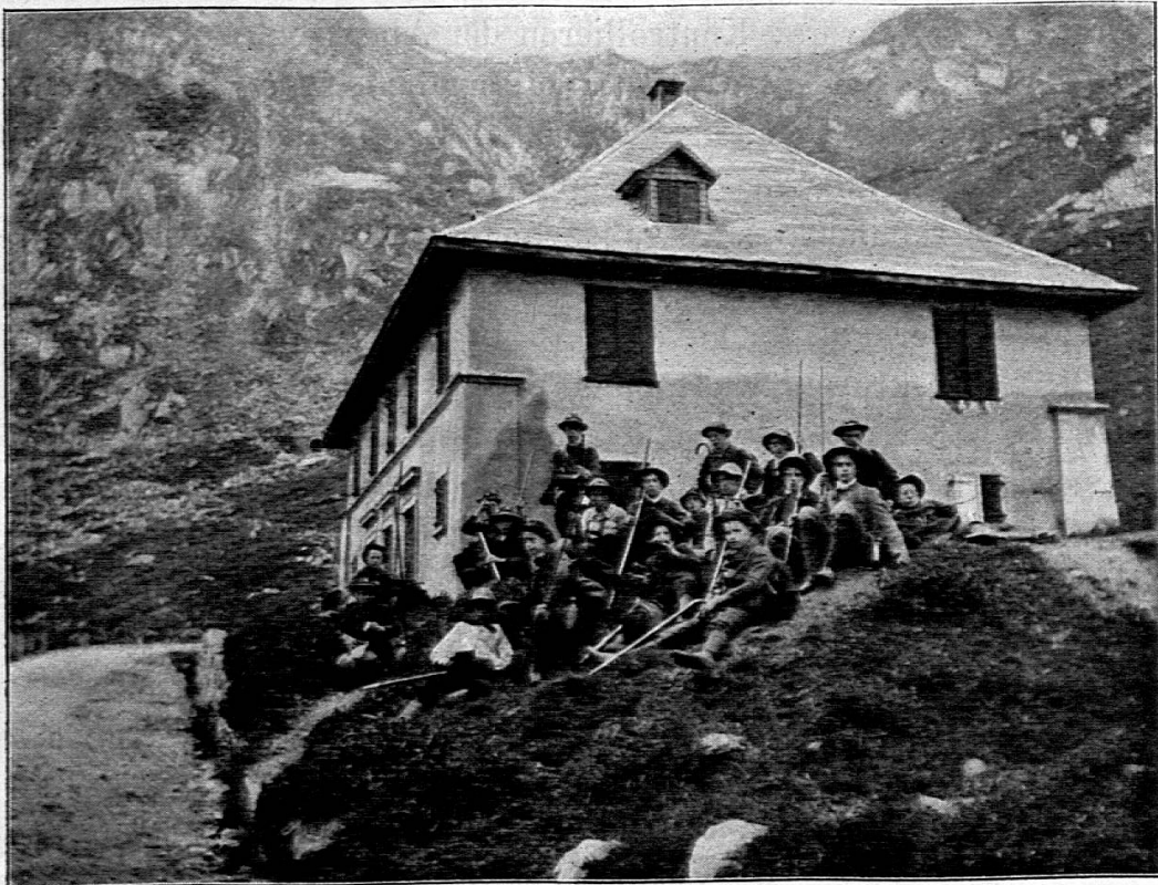
Mätteli-Baracke an der Gotthardstrasse.
