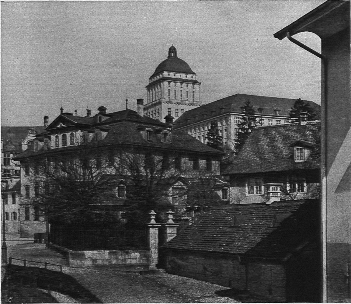
Ansicht vom Hirschengraben aus mit Verwaltungsgebäude zum Rechberg
