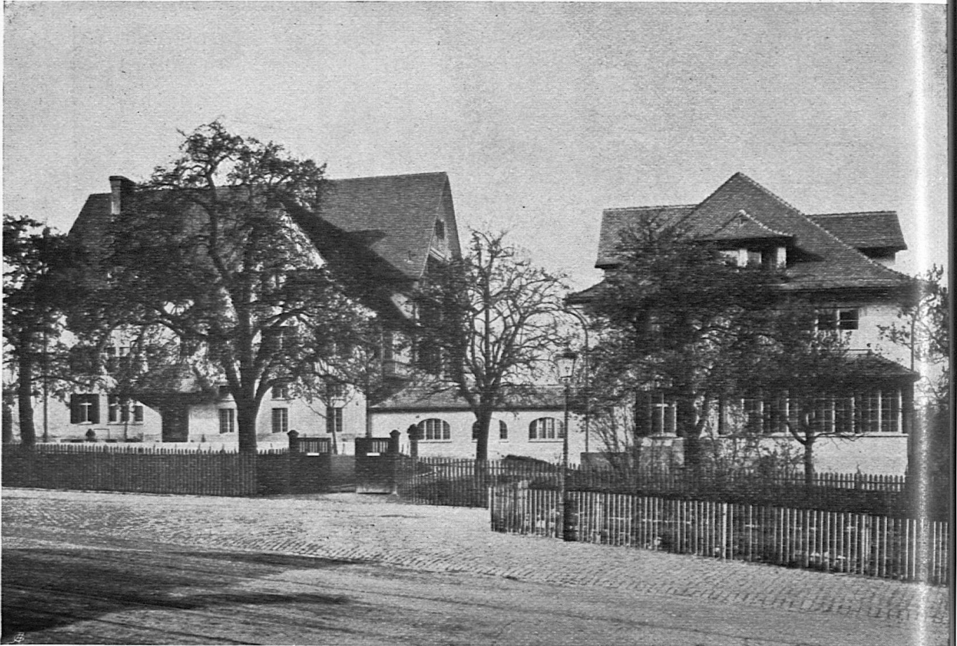
Anstalt Balgrist. — Haupt- und Nebengebäude (für die orthopädische Poliklinik, die erwachsenen Internen und die Arztwohnung). — Ansicht gegen die Forchstraße.
