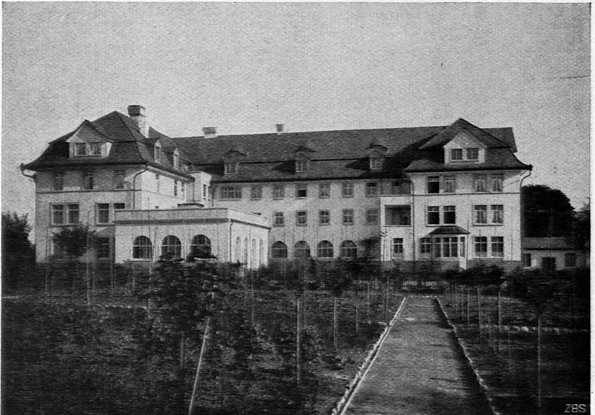
Kantonale Blinden- und Taubstummenanstalt in Zürich. Ansicht der Nordfassade.
