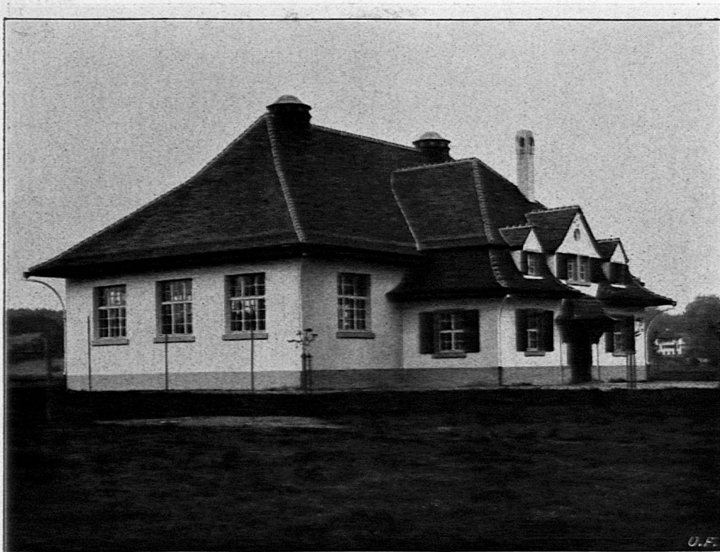
Die neue Turnhalle in Langenthal. — Außenansicht.
