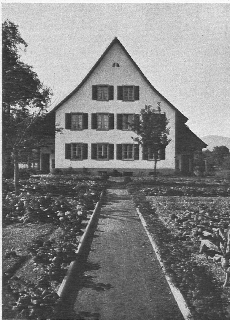
Typ. C. Doppeleinfamilienhaus für Angestellte und Meister in Schönenwerd, Gretzenbach und Ober-Gösgen - Erbaut 1919
