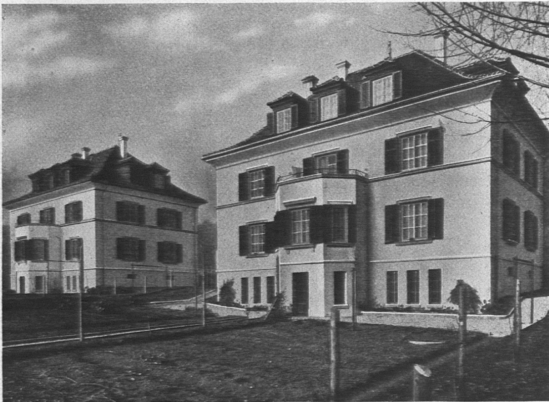
Zweifamilienhäuser für Angestellte in Nieder-Gösgen - Erbaut 1918/19
