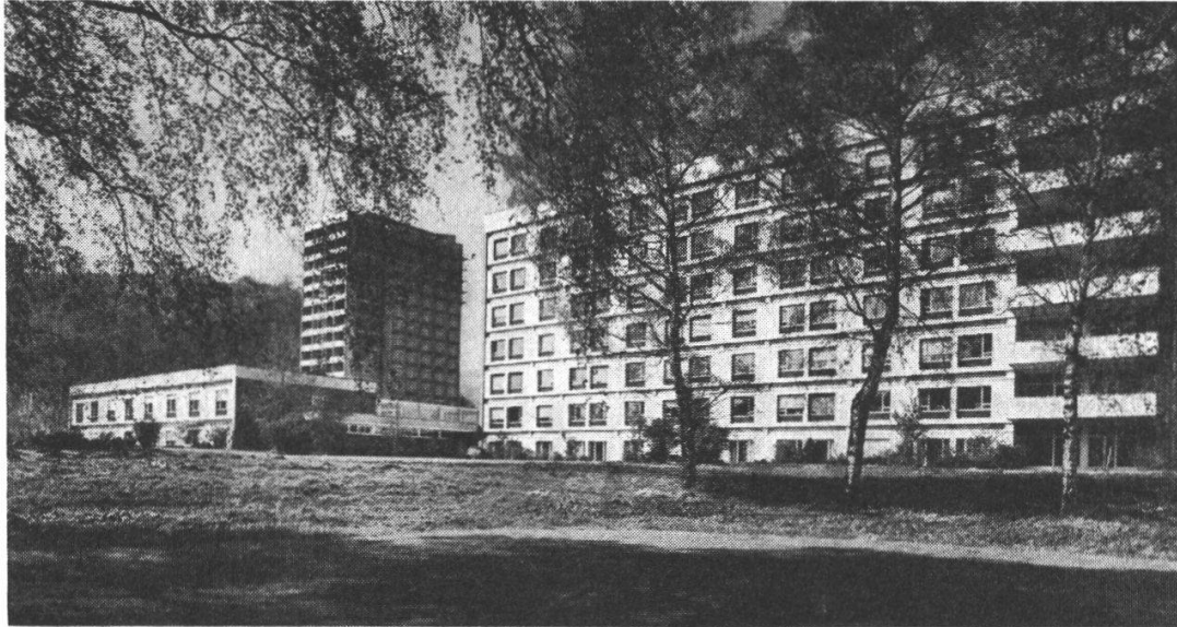
1966. Rechts grosses Bettenhaus, in der Mitte Angestellten- und Schwesternhaus, links Infektionsgebäude.
