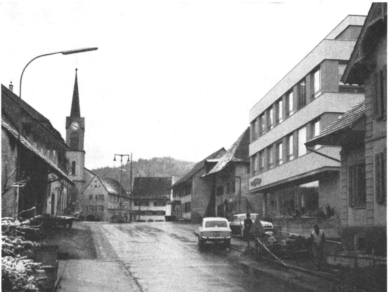
Abb. 2. Niedererlinsbach: Neubau Von Däniken.
