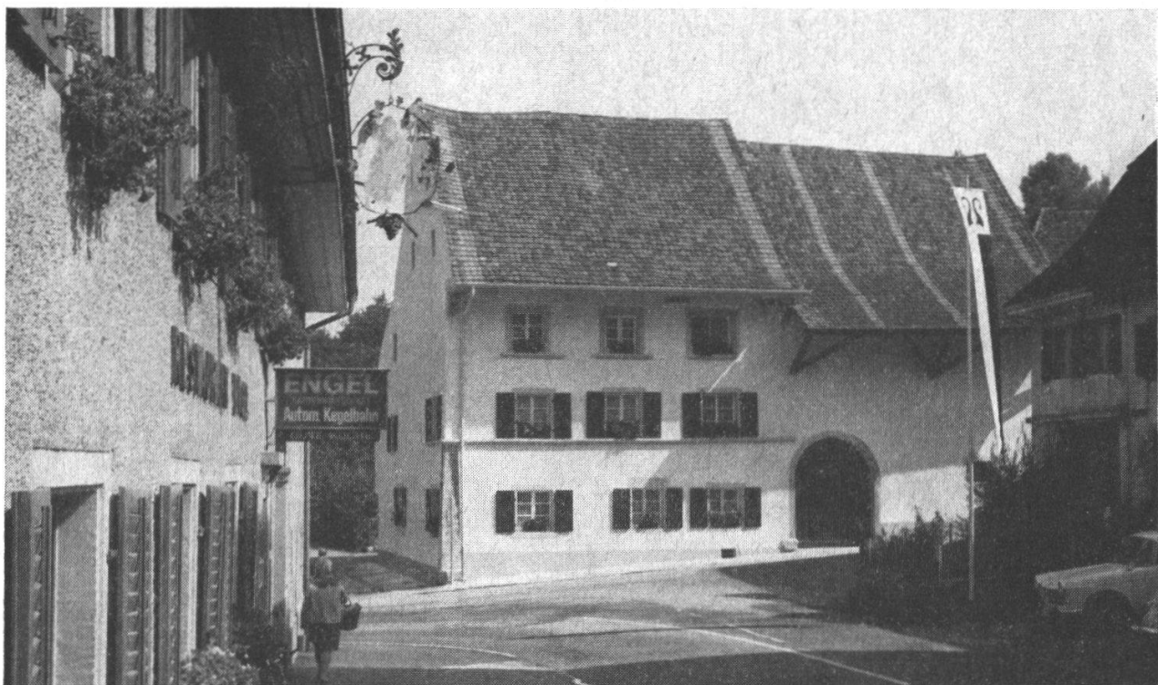
Abb. 6. Dornach: Bauernhaus Gasser, Kohliberg 1, nach der Restaurierung der Fassaden und der Sanierung der Scheune. Links Restaurant «Engel».
