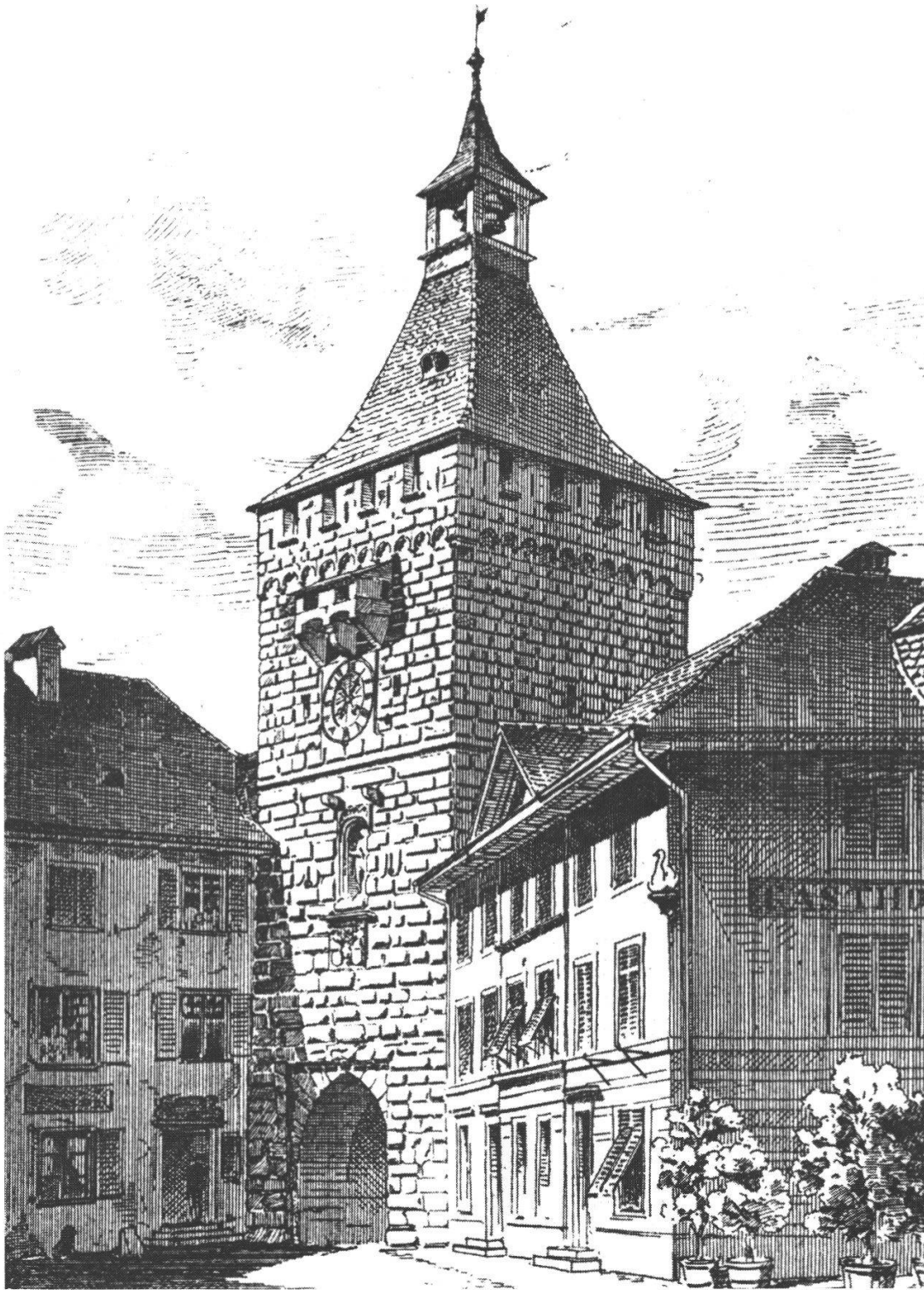
Figur 8: Inneres Berntor, äussere Ansicht. (Widmer nach Fotografie), Quelle: J.R. Rahn, Mittelalterliche Kunstdenkmäler des Cantons Solothurn , 1893. Über dem Torbogen ist das WR deutlich zu erkennen. Das Tor wurde um 1480 erbaut (E. Schlatter) und im Juli 1877 geschleift (J.R. Rahn).
