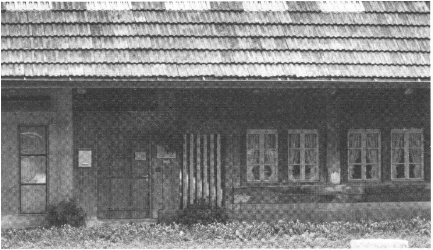
Abb. 6: Geschweifte Streben der Hochstudkonstruktion, die stilistisch in die 2. Hälfte des 16. Jahrhunderts zu datieren ist.
