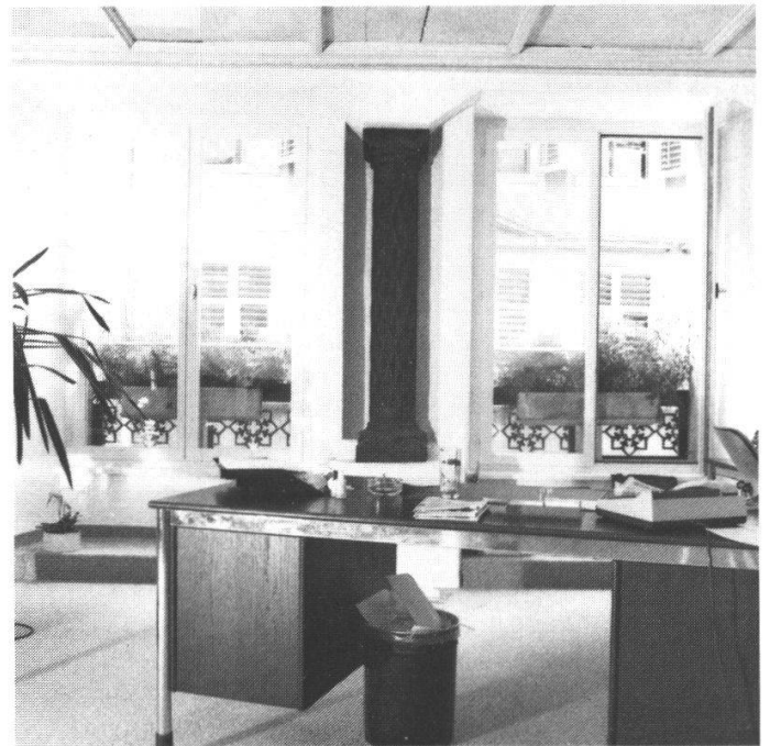
Abb. 5: ... und die gleiche Aufnahme nach der Freilegung und Restaurierung der Säule.
