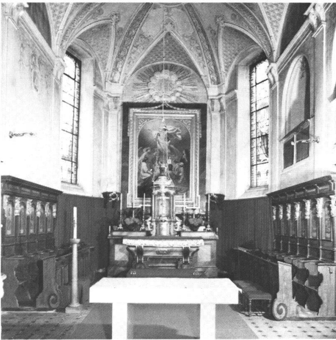
Abb. 1: Der Chorraum vor der Restaurierung von 1970. Hochaltar und Chorgestühl in originaler Position. Dekorationsmalerei der Jahrhundertwende.
