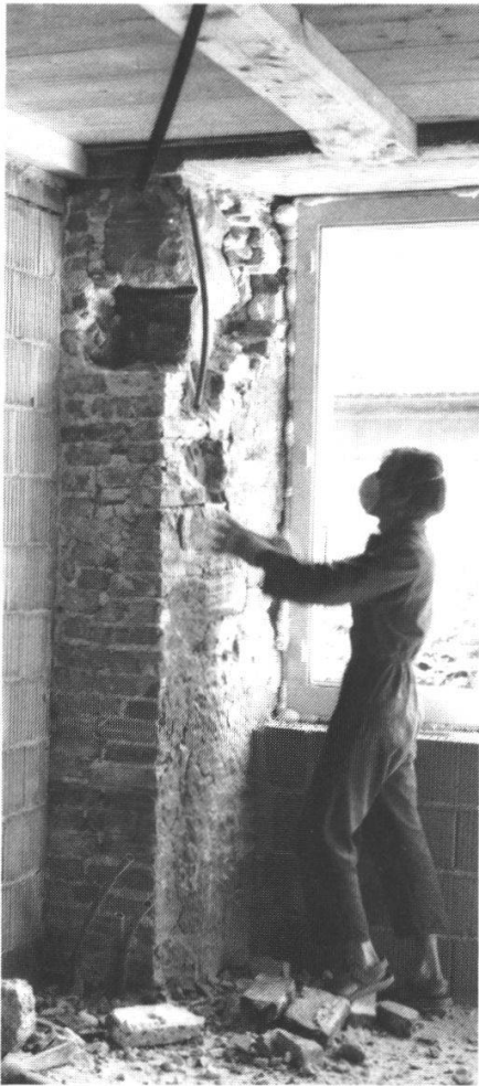
Abb. 7: Südflügel 1. Obergeschoss. Entdeckung und Freilegung der Fenstersäule von ca. 1550.
