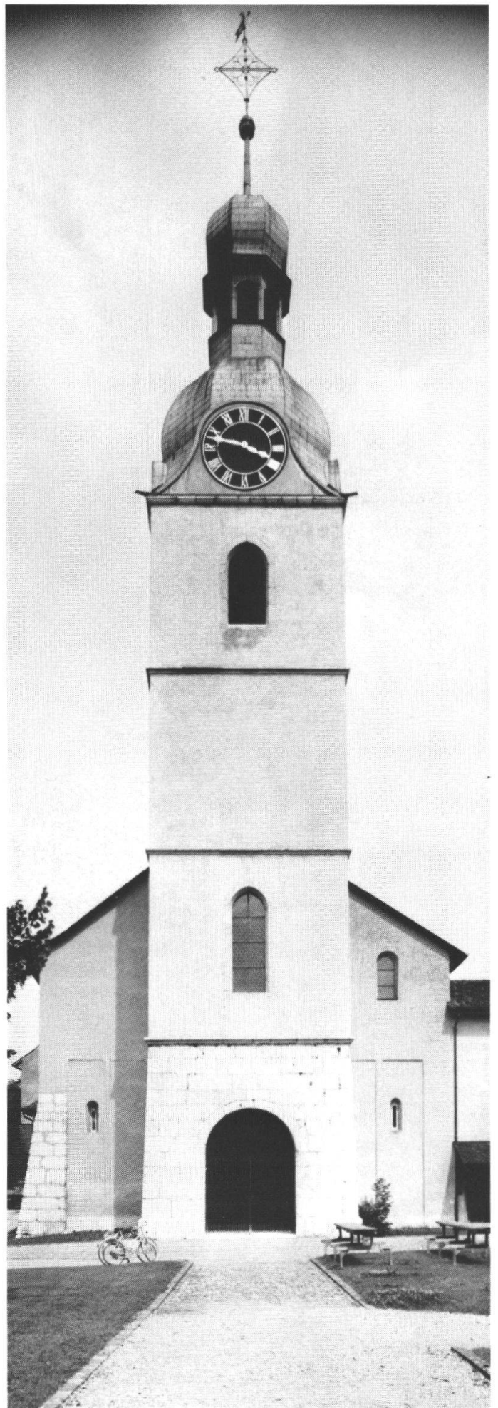
Abb. 4: Nach der Restaurierung von 1989. Aufnahme 1990.
