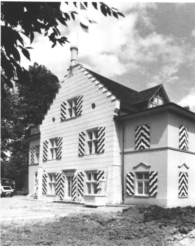
Abb. 15: Südwestansicht nach Restaurierung und Umbau 1988/90.
