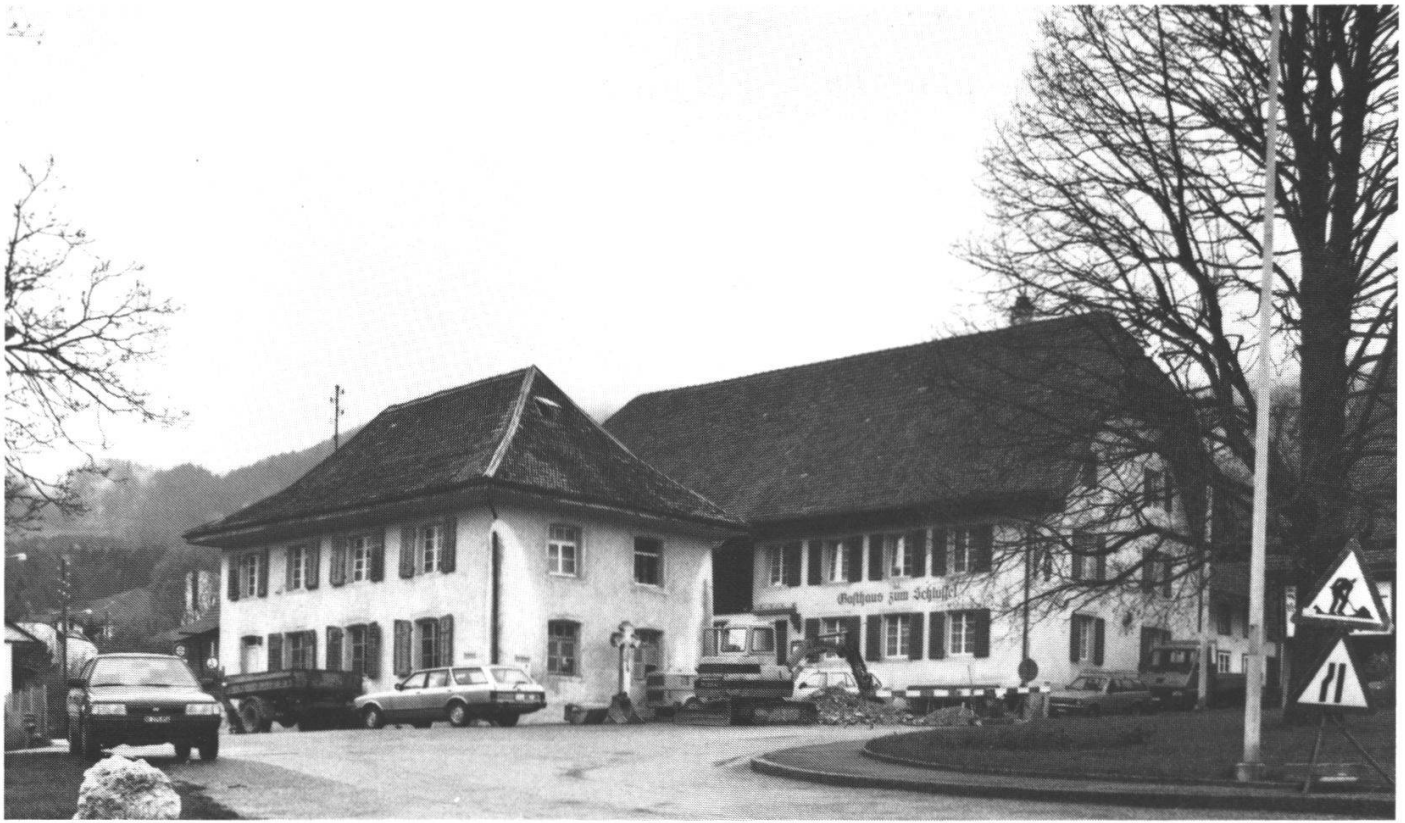
Abb. 2: Aufnahme kurz vor dem Abbruch April 1989.
