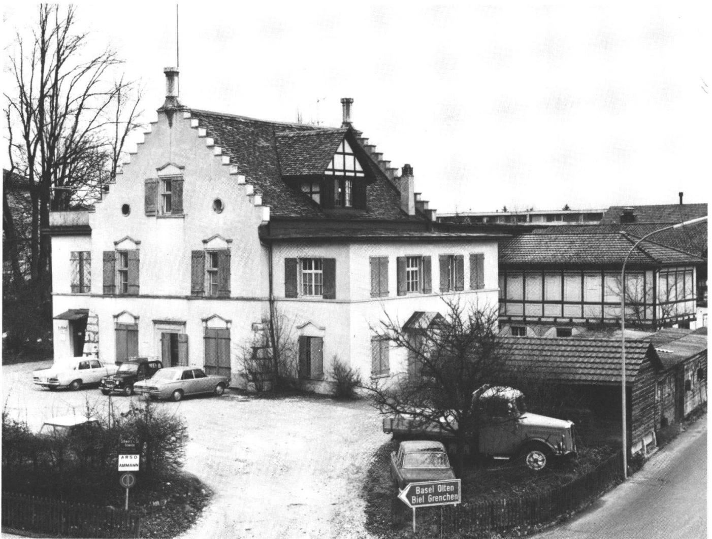
Abb. 14: Südwestansicht vor Restaurierung und Umbau 1988/90.
