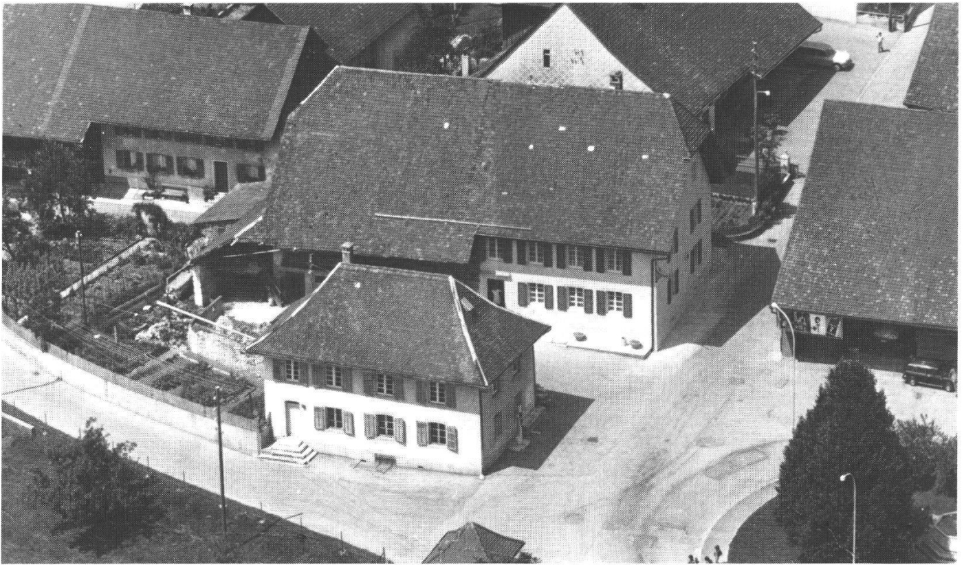
Abb. 1: Flugaufnahme um 1960: Restaurant «Schlüssel» mit dem alten Schulhaus.
