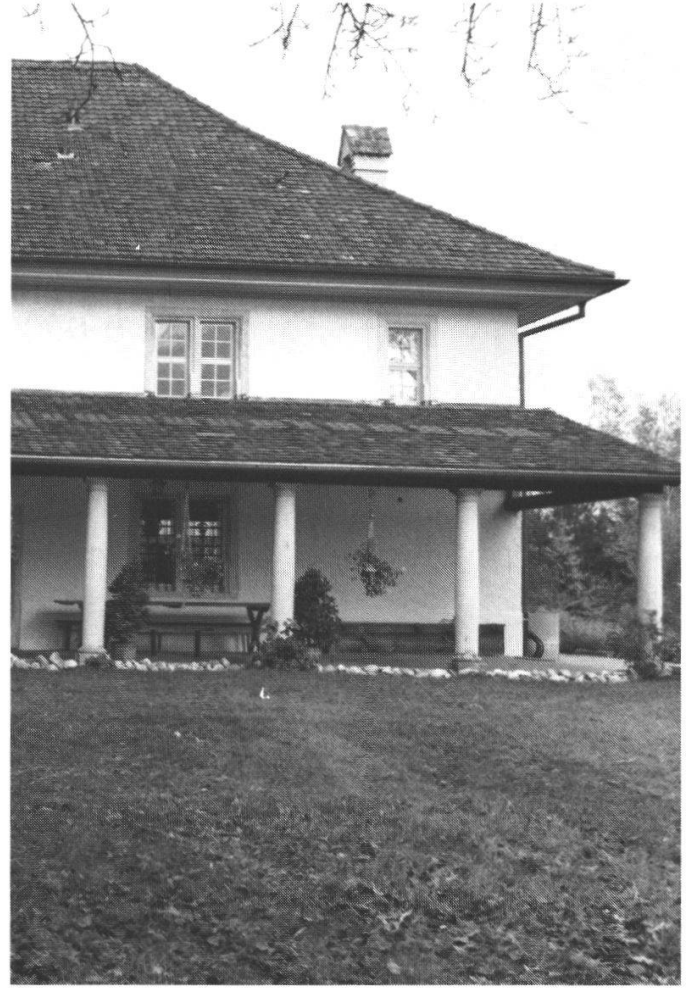
Abb. 2: Westfassade, Vorhalle mit zurückgeklapptem Pultdach, Ausschnitt, 1990
