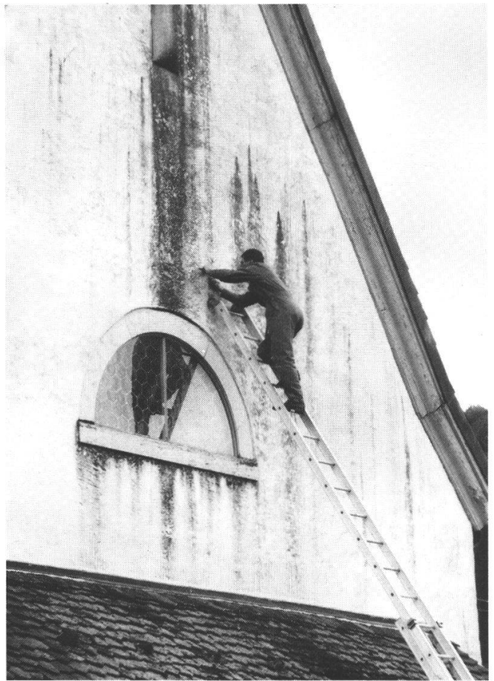
Abb. 2: Probenentnahme bei den Algen- und Flechtenkolonien, die auf der Westseite gewachsen waren.
