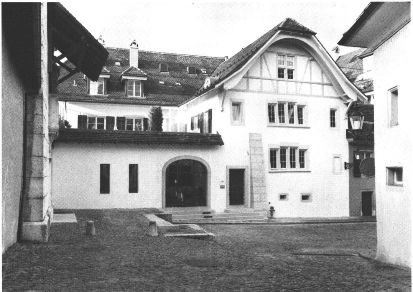
Abb. 2.: Nordseite nach dem Umbau
