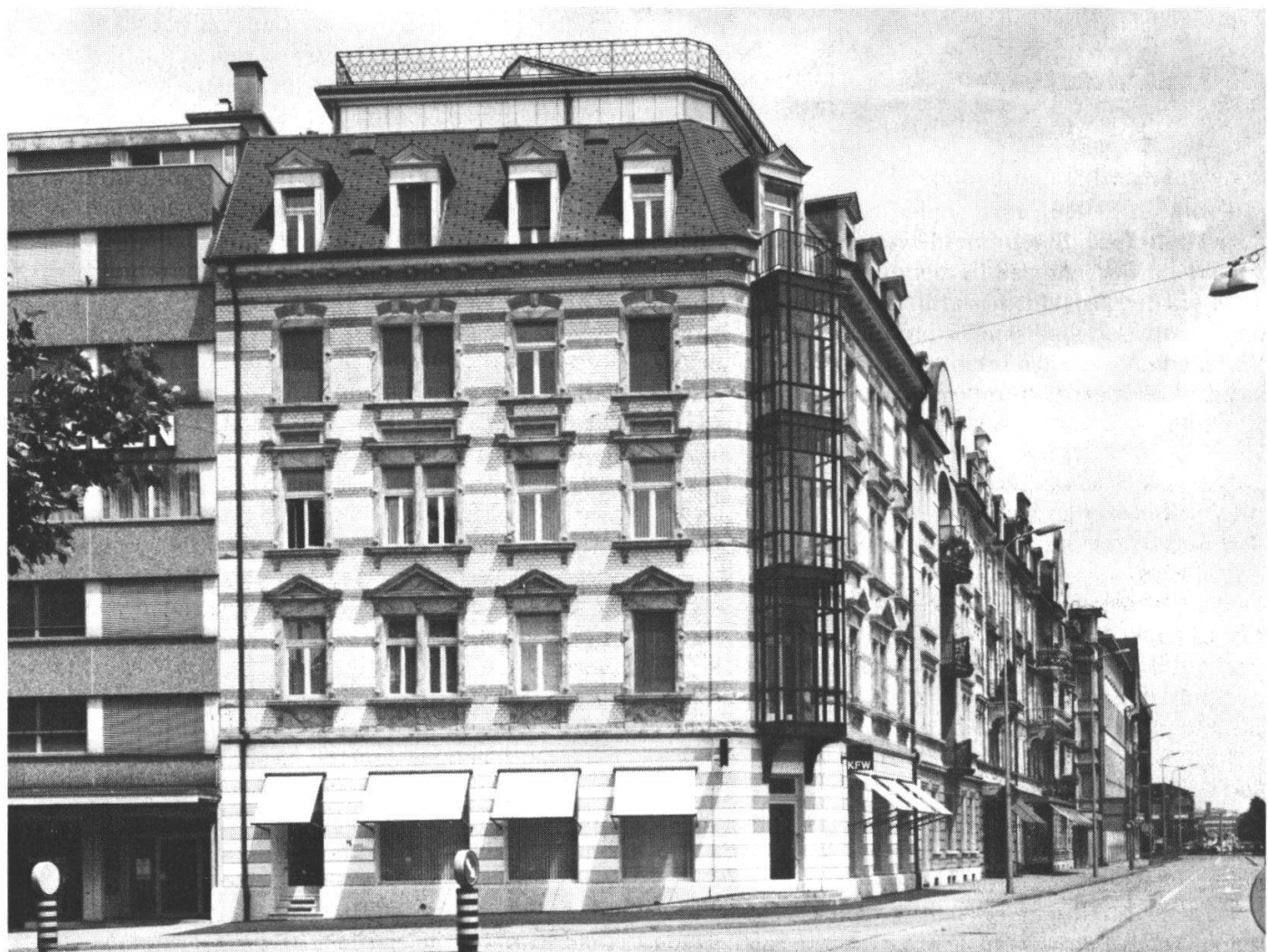
Abb. 3: Zustand 1990 nach Umbau und Restaurierung: Aufstockung, massstäbliche Neugestaltung von Erdgeschoss und Erkerelement. Die Farbgestaltung ist aus der Abbildung S. 149 ersichtlich.
