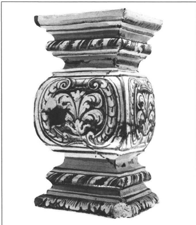
Abb. 10: 1.OG, Raum nördlich des Treppenhauses, Stuckprofil beim Anschluss Wand/Decke aus der Bauzeit des Palais. 1988/89 zerstört.
