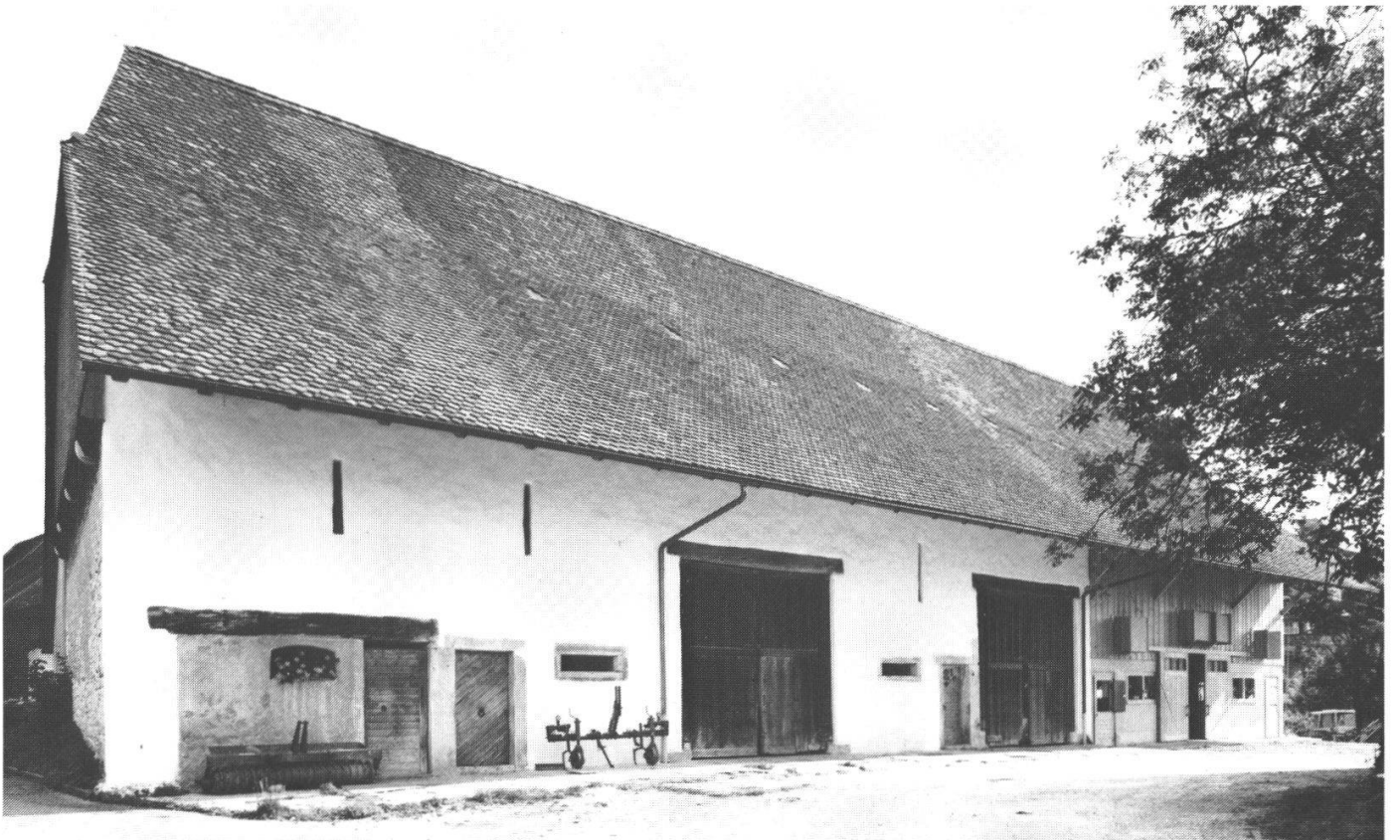
Abb. 5: Die restaurierte Scheune mit dem neuen Stallanbau rechts aussen.
