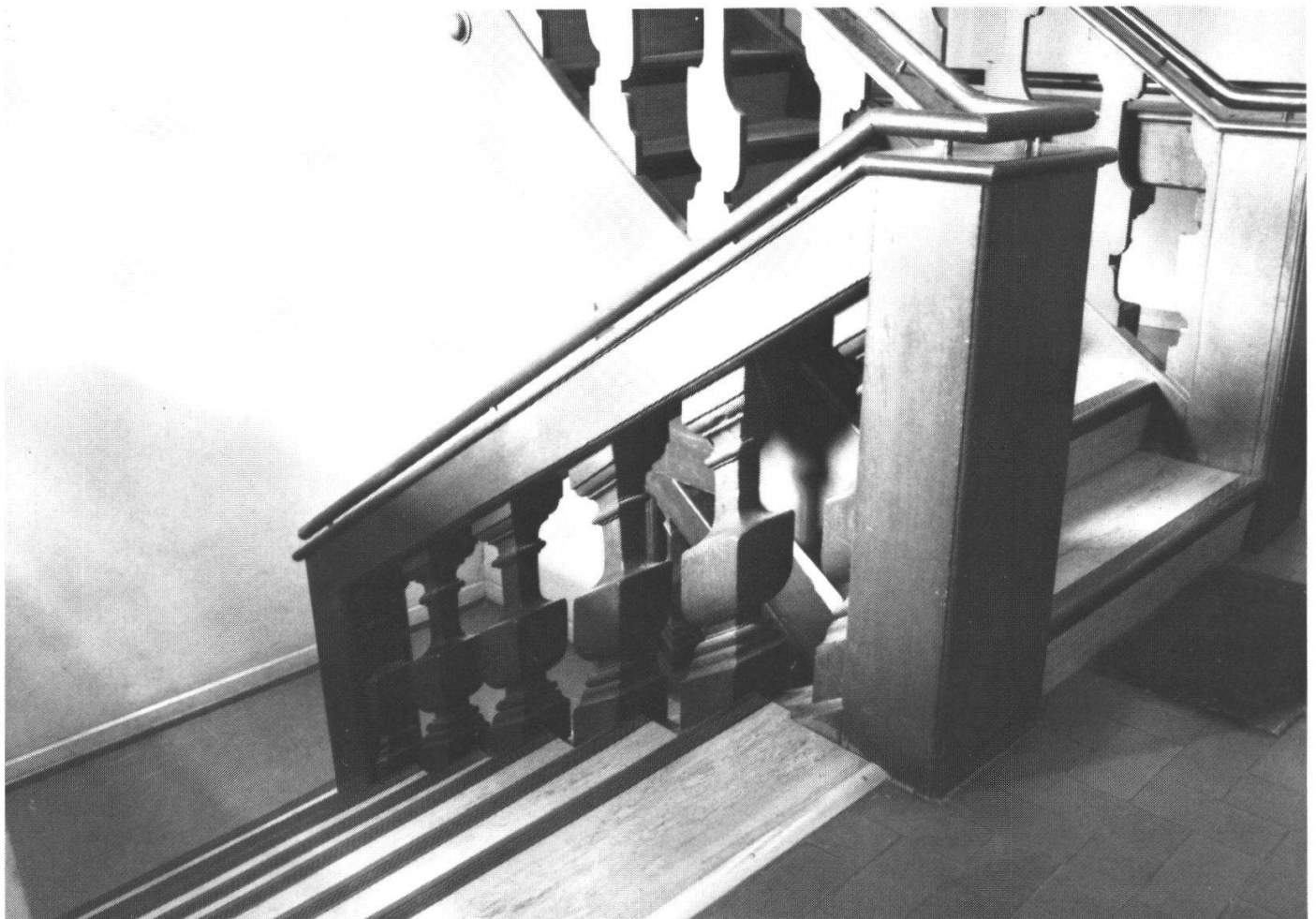
Abb. 8: Die Treppenanlage aus dem frühen 18. Jahrhundert, Zustand vor dem Umbau
