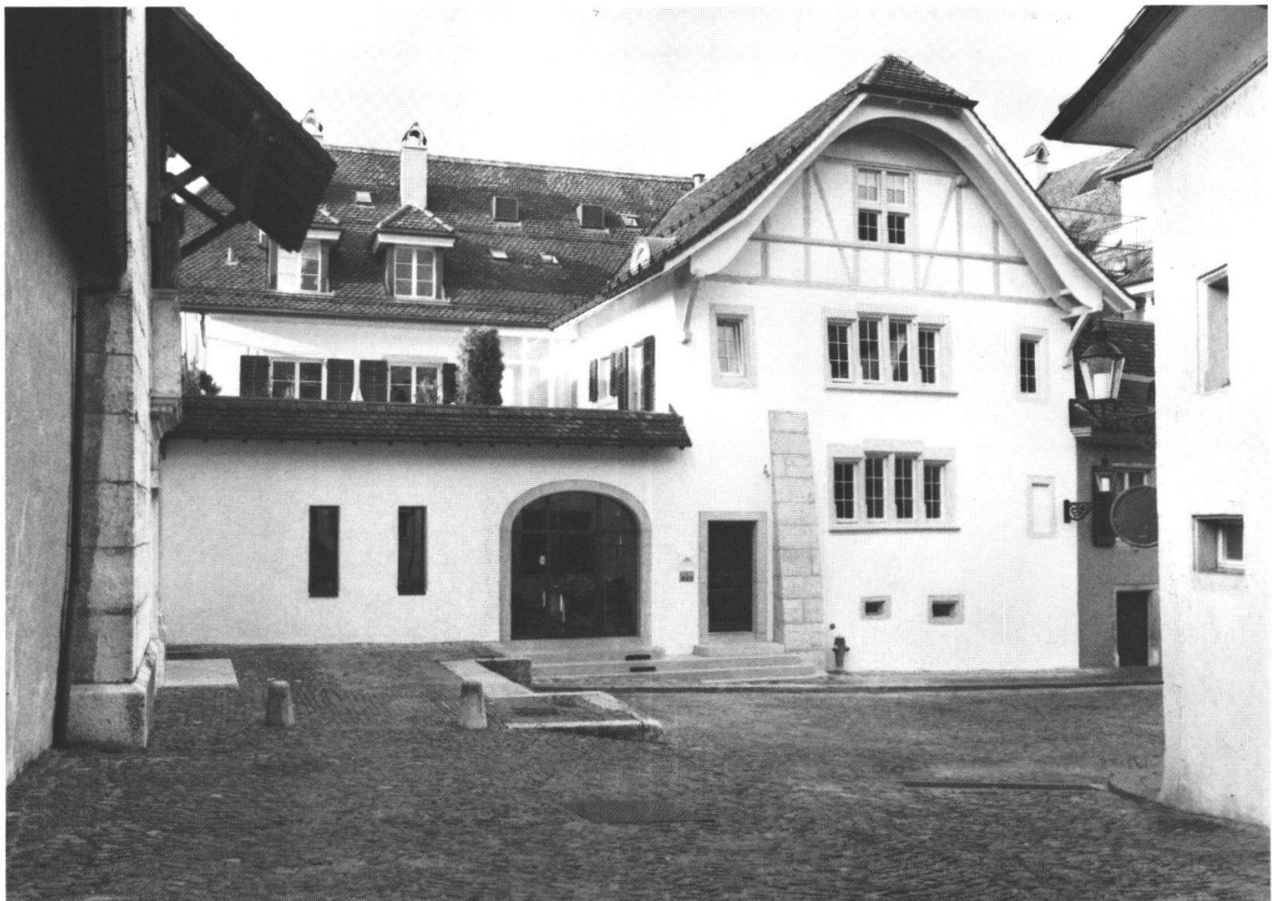
Abb. 2.: Nordseite nach dem Umbau
