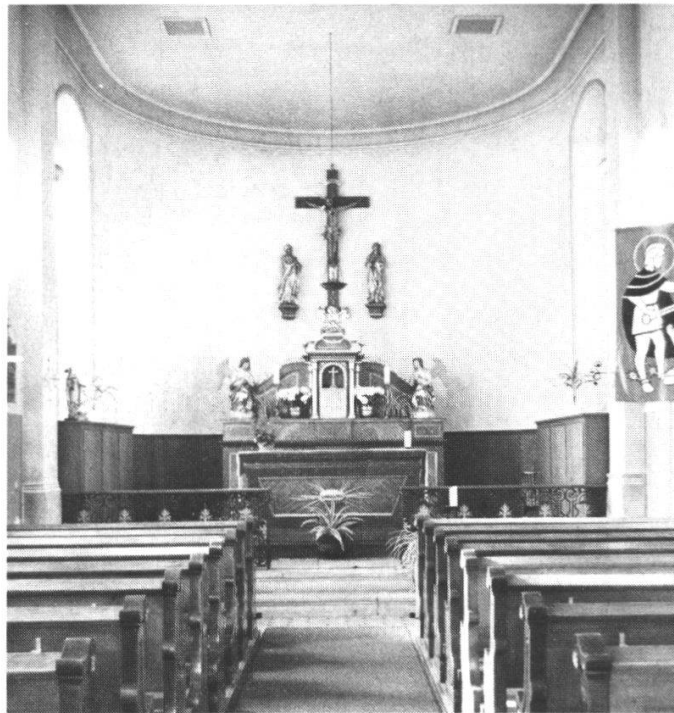
Abb. 2: Aufnahme von 1984 mit der 1956 neu erstellten Gipsdecke. Die Stuckornamente sind entfernt. Über dem Altar der Kruzifixus, flankiert von neuen Statuen Maria und Johannes.
