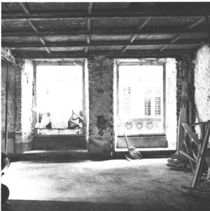
Abb. 4: Stube 1. Obergeschoss, Blick nach der Fensterfront, in der Bildmitte die ummauerte Fenstersäule, die durch ein kleines Sondierloch sichtbar ist...
