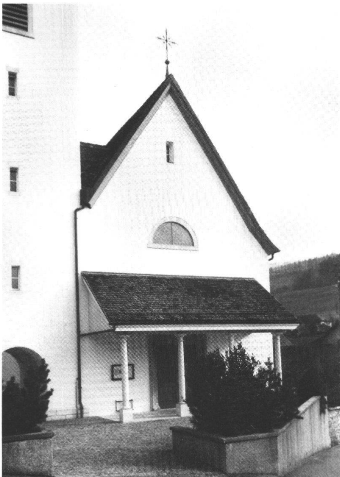
Abb. 3: Die neu gekalkte Westfassade.
