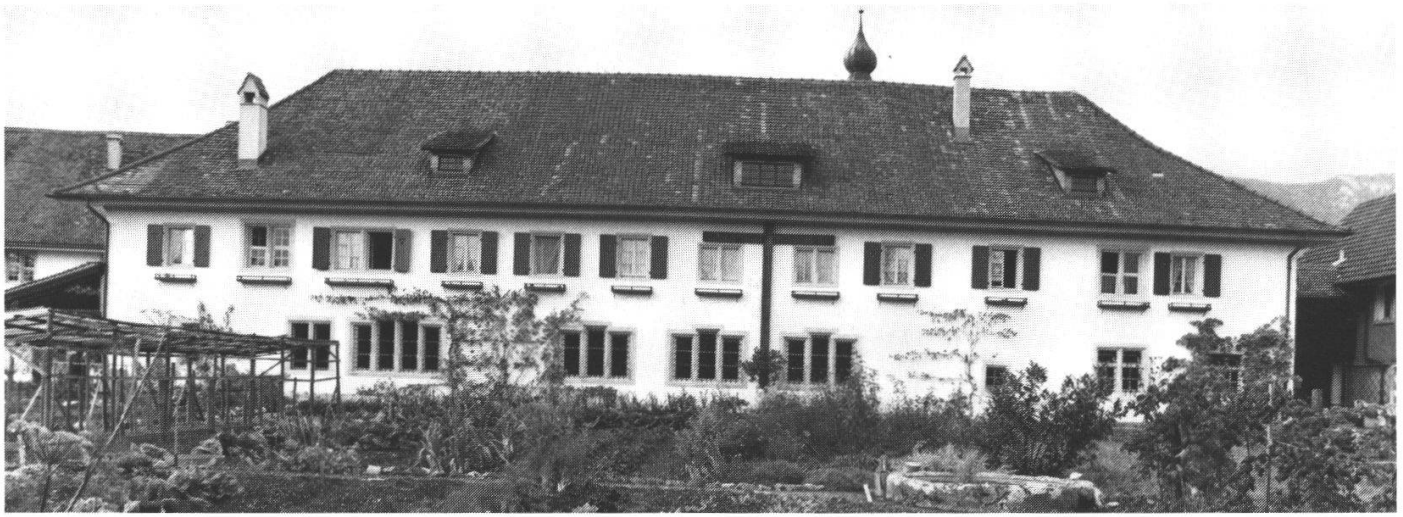
Abb. 4: Die restaurierte Südfassade, 1990. An der Fassade sind die Funktionen der dahinterliegenden Räume abzulesen: Hinter den mittleren drei Staffelfenstern befindet sich das Refektorium, links davon, hinter dem vierteiligen Staffelfenster, das ehemalige Krankenzimmer, rechts die Küche. Im Obergeschoss unterscheiden sich die Gangfenster durch ihre grösseren Dimensionen von den (in dieser Form jungen) Zellenfenstern.
