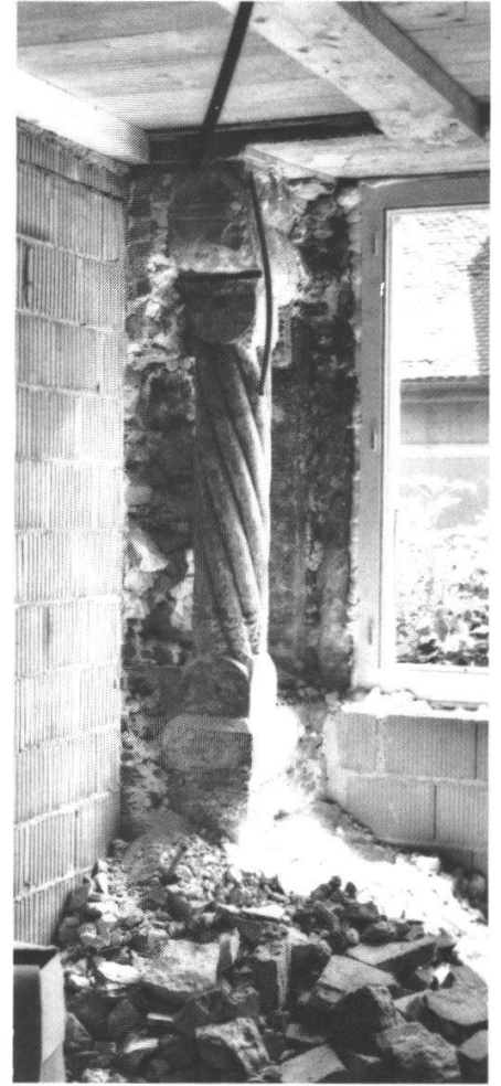
Abb. 7: Südflügel 1. Obergeschoss. Entdeckung und Freilegung der Fenstersäule von ca. 1550.
