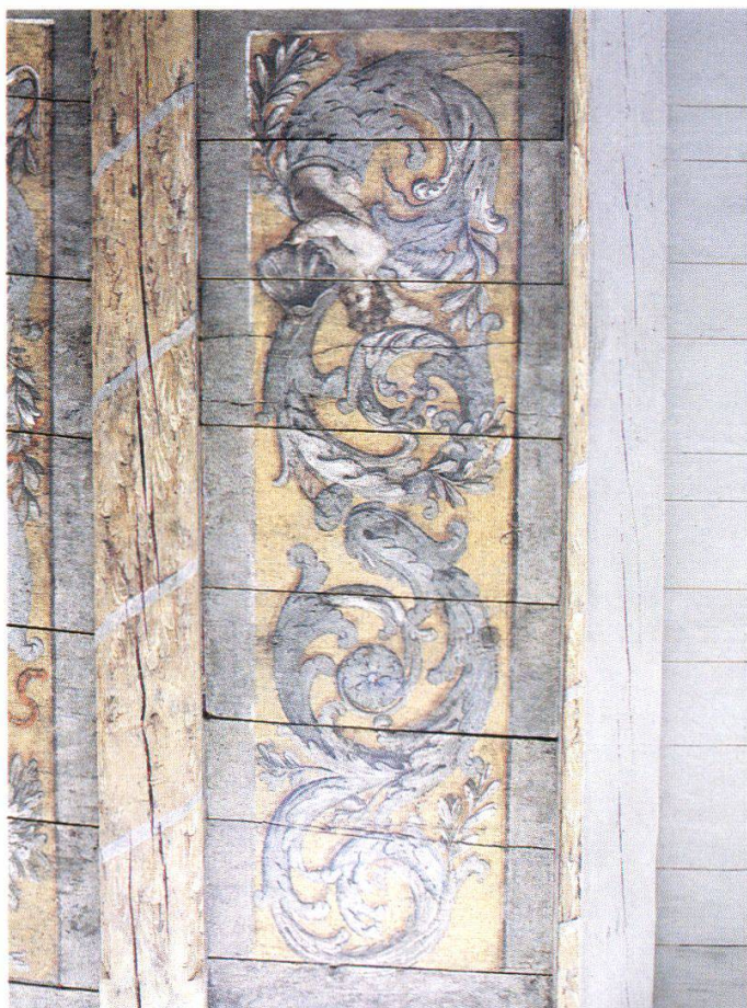
Abb. 9: Südflügel 1. Obergeschoss. Ausschnitt aus der bemalten Decke, wohl aus dem späten 17. Jahrhundert, Zustand nach der Restaurierung
