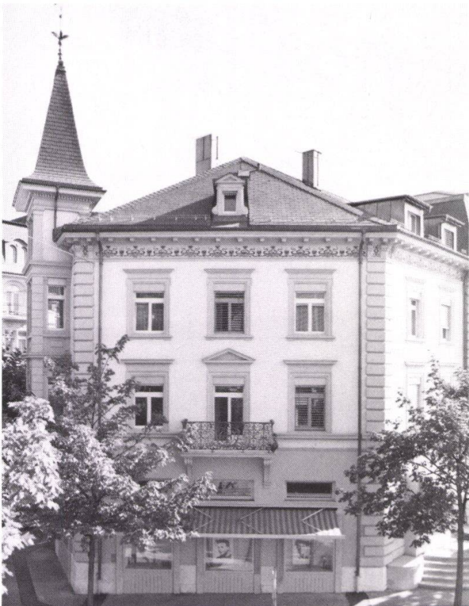
Abb. 7: Die Fassade an der Hauptbahnhofstrasse, nach der Renovation.
