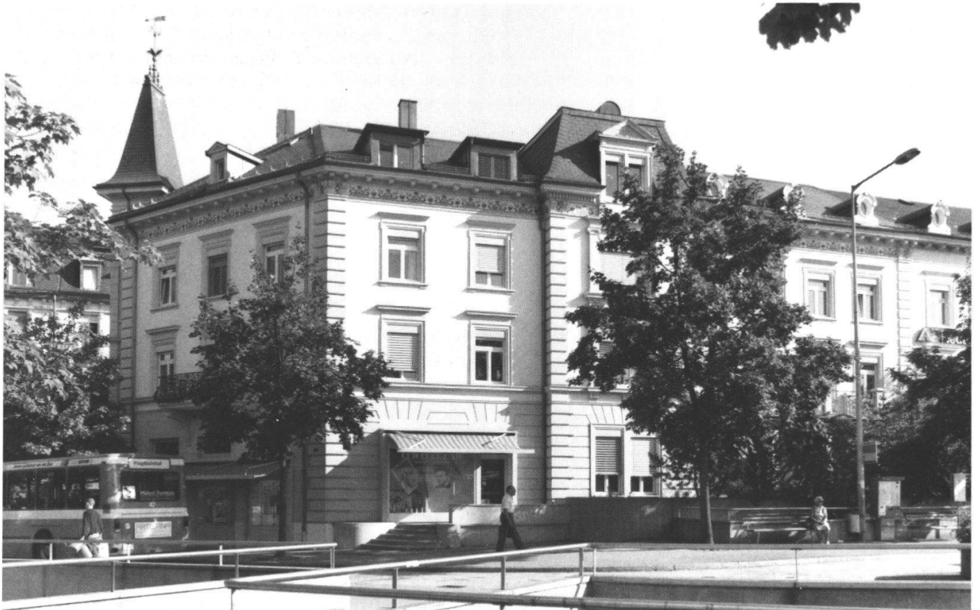
Abb. 5: Südansicht der Liegenschaft Hauptbahnhofstrasse 9/Niklaus Konradstrasse 18, nach der Renovation.
