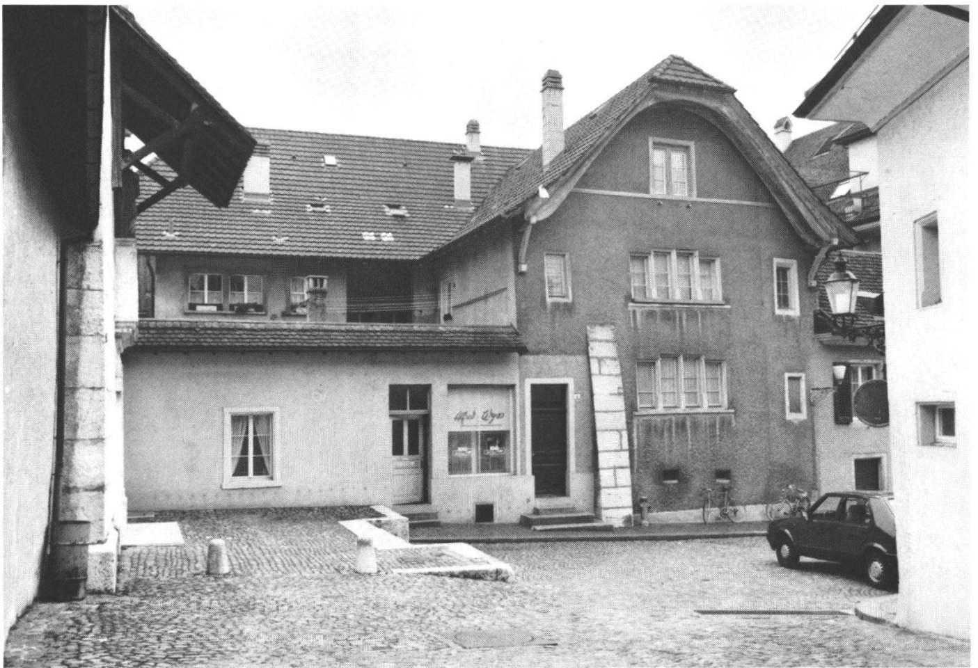
Abb. 1: Nordseite vor dem Umbau
