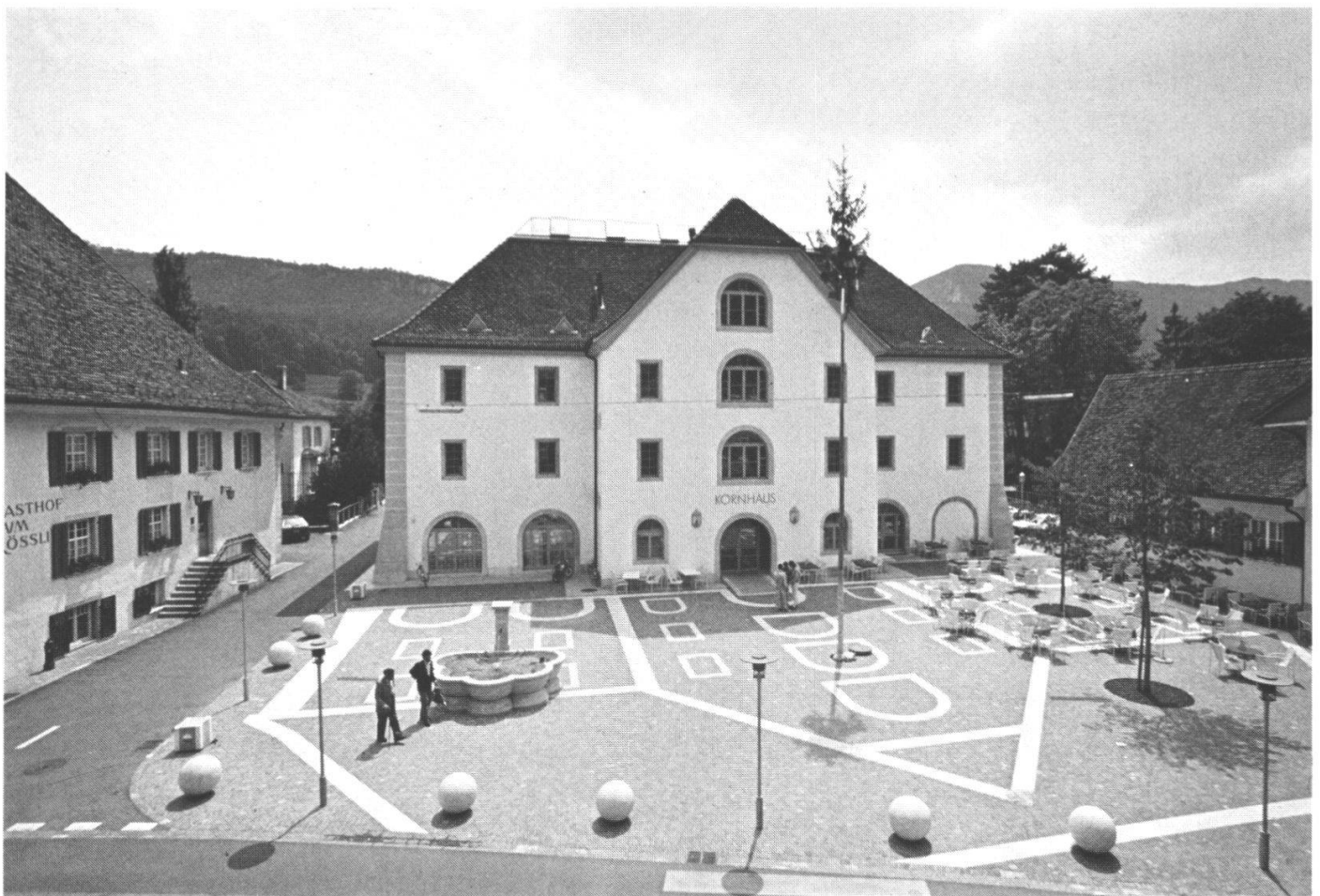
Abb.: Der autofreie Kreuzplatz mit der neuen Natursteinpflasterung und dem restaurierten Brunnen. Die angrenzenden Häuser sind von links nach rechts: das Hotel Rössli, das ehem. Kornhaus, das Hotel Kreuz.
