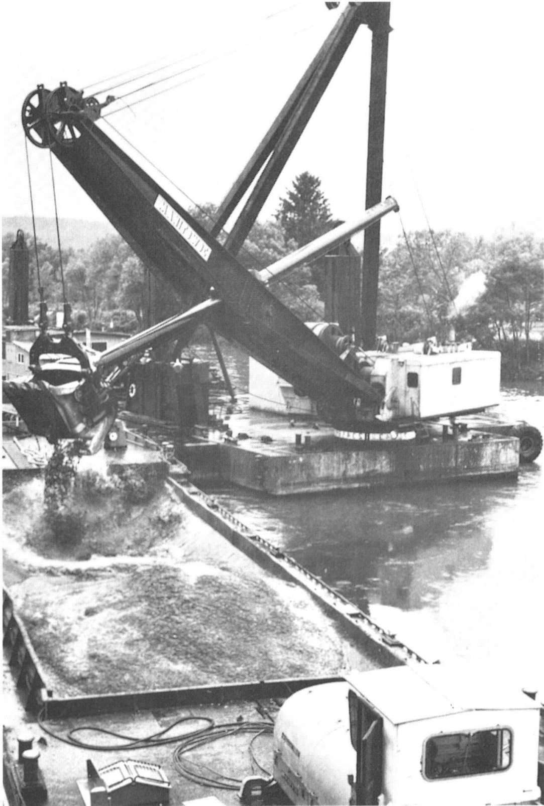
Abb. 16: Der Manitowoc-Schwimmbagger (Gewicht 600 t) mit Selbstfahrer-Klappschiff 500 t, Füllzeit 30–45 Minuten. (Quelle: Die Korrektio[n] des Nidau–Büren-Kanals und der Aare bis zur Emmemündung, 1974, 6)
