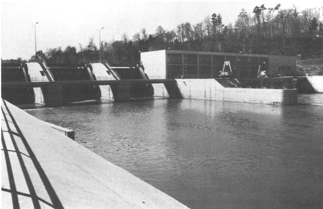
Abb. 26: Kraftwerk Flumenthal. Blick vom Unterwasser auf die Wehranlage und das Maschinenhaus. (Aus: Abschliessender Bericht über die 2. JGK, 1974)
