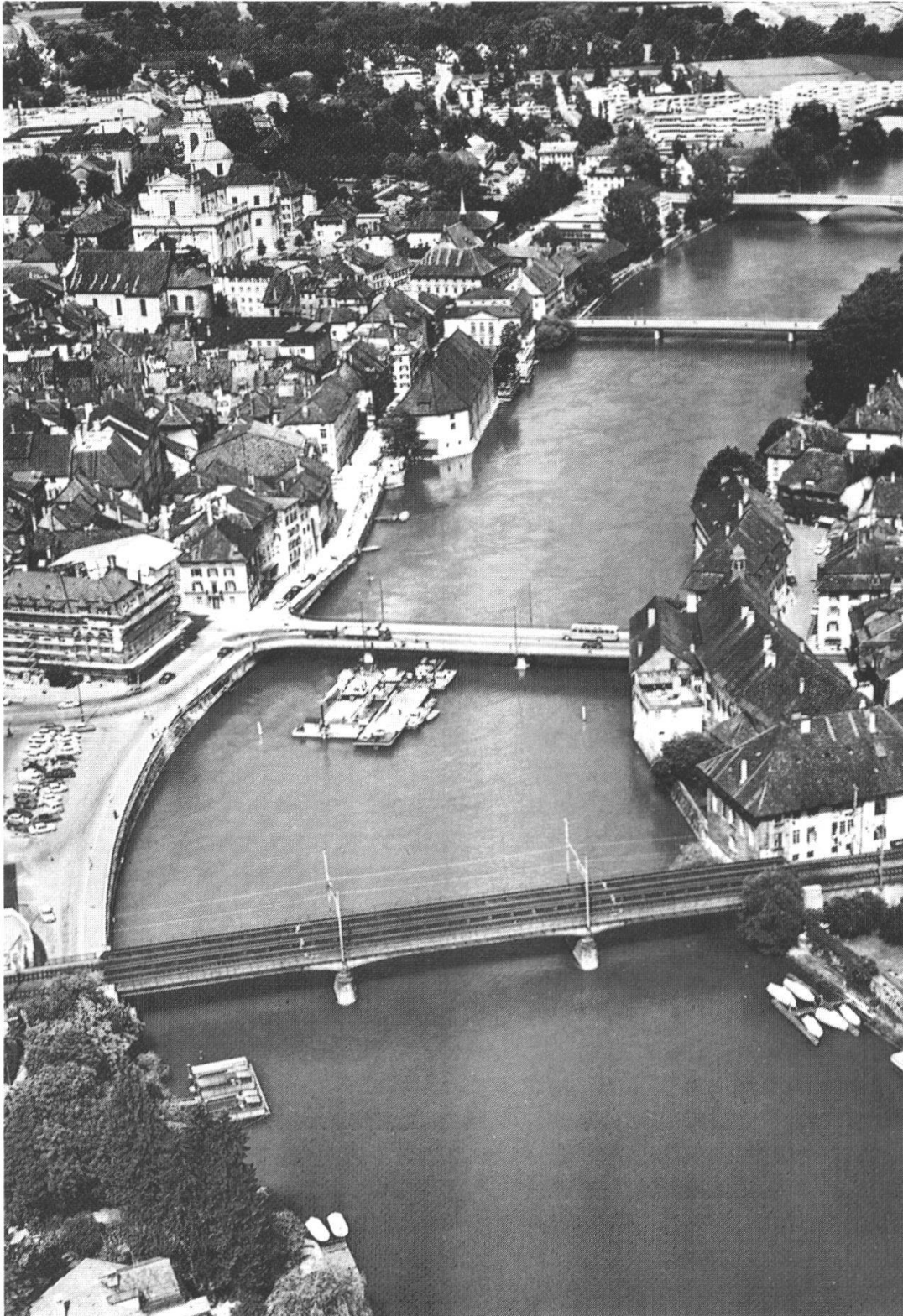
Abb. 19: Stadt Solothurn. Ausgleichen und Sichern der Sohle zwischen den Brücken. (Die Korrektion des Nidau-Büren-Kanals, 1974, 60)
