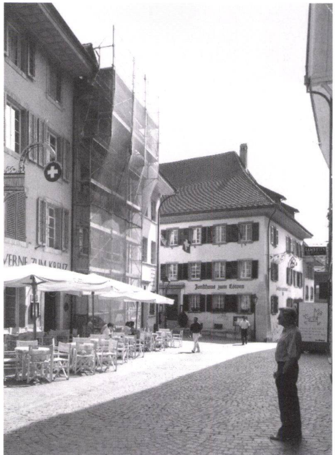
Abb. 2: Das Haus Hauptgasse 14 während des Umbaus.
