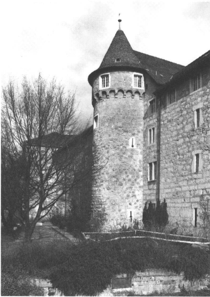
Abb. 2: Der Turm am Kosthaus. Die beiden obersten Geschosse wurden um 1443/44 aufgesetzt.
