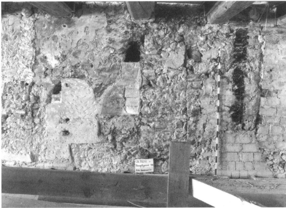
Abb. 3: Brandmauer Ost, 1. Obergeschoss, Mittelpartie. Jede Bauphase hat ihre Spuren hinterlassen. Die Entwirrung derartiger Befunde ist aufwendig, heikel, aber auch lohnend.
