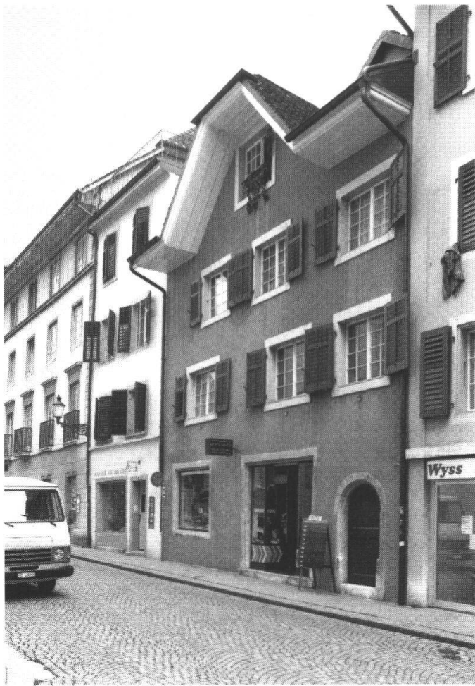
Abb. 1: Die beiden Häuser Theatergasse Nr. 14 (rechts) und Nr. 16 (links).
