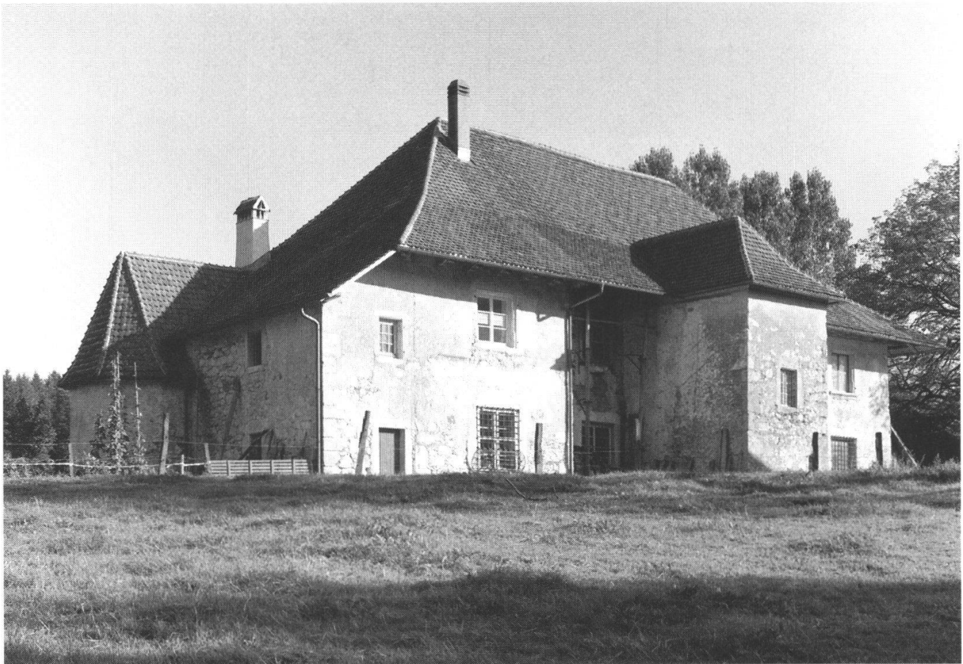
Abb. 2: Nordfassade mit dem späteren Treppenturm in der Mitte.
