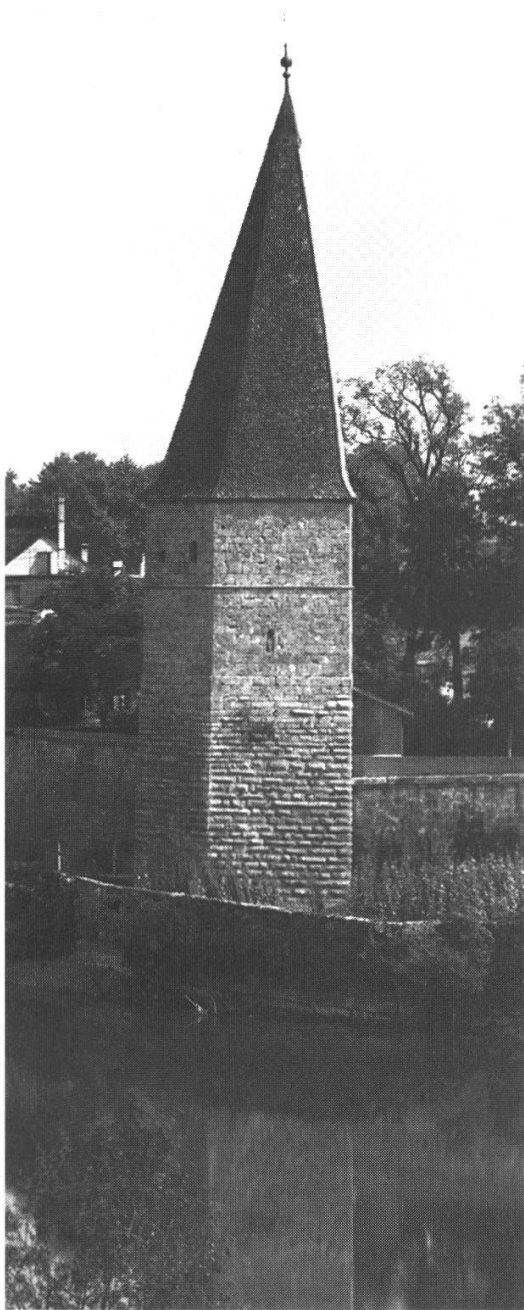
Abb. 4: Der Krummturm in der Solothurner Vorstadt ist identisch mit dem in zeitgenössischen Quellen von 1462/63 «nüwen Thurn in der Vorstatt» genannten Bau. Seine Sockelpartie mit Kalksteinbossenquadern stammt noch aus dem 13. Jahrhundert, die Obergeschosse aus Tuffquadern sind 1462/63 aufgesetzt worden. (Dendroproben 289 SO – 306 SO)
