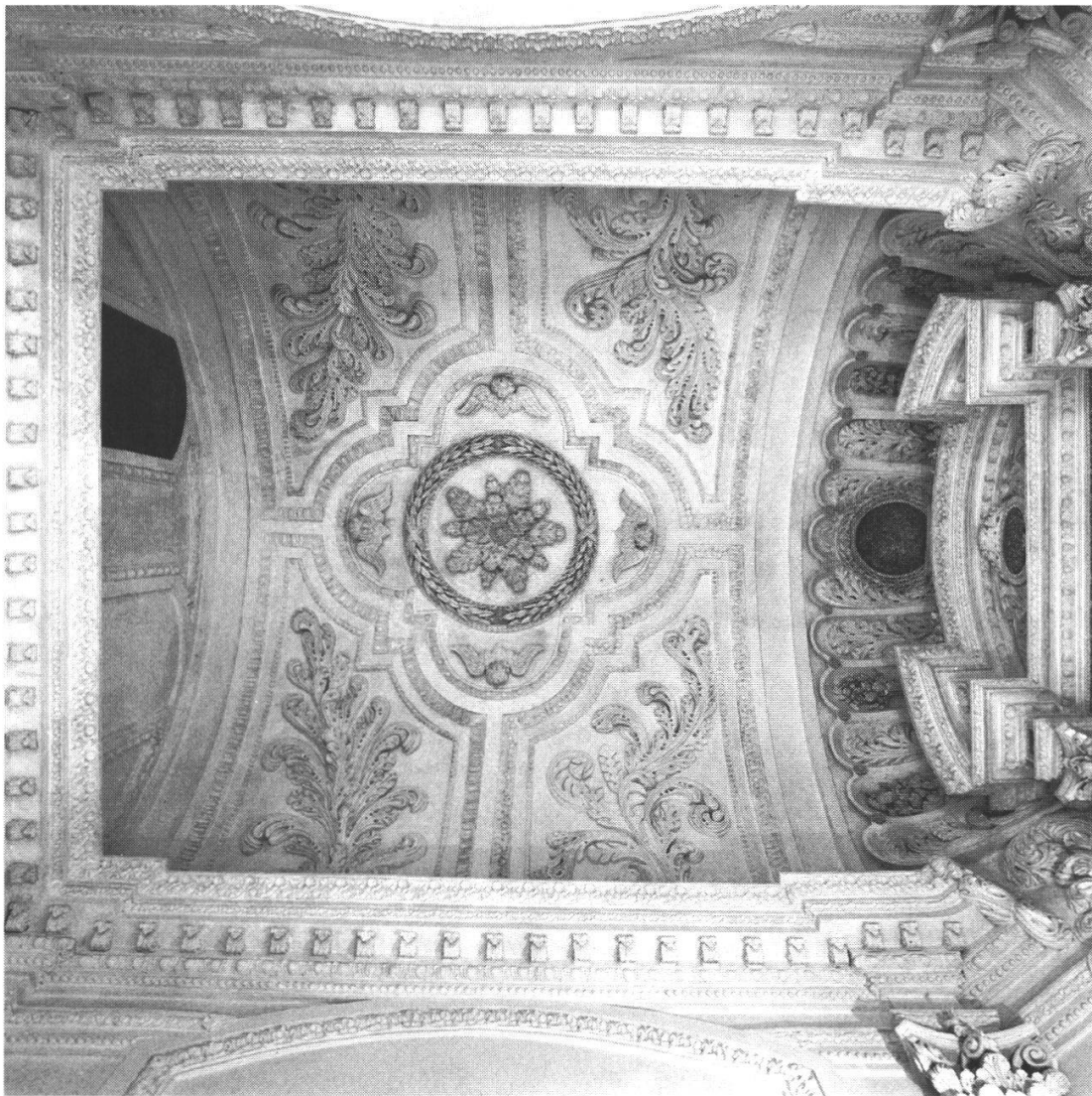
Abb. 5: Ansicht der gewölbten und stukkerten Decke der Hauskapelle.
