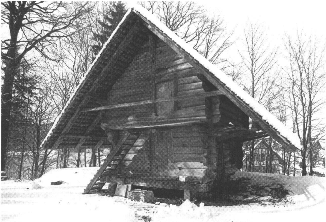
Abb. 7: Einer der ältesten ganz aus Holz erstellten Bucheggberger Speicher aus Brügglen steht heute beim Schloss Buchegg. Er ist 1503 konstruiert worden (Dendroproben 382 SO – 386 SO)
