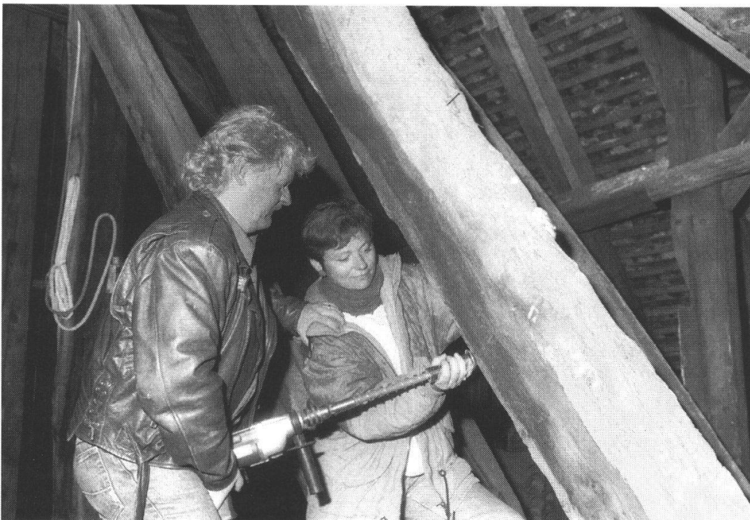
Abb. 2: Dendrochronologen an der Arbeit. Der Spezialist für die Holzdatierung weiss aus Erfahrung, wo und in welchem Winkel er die Bohrmaschine zur Probeentnahme ansetzen muss, um zu optimalen Resultaten zu kommen.
