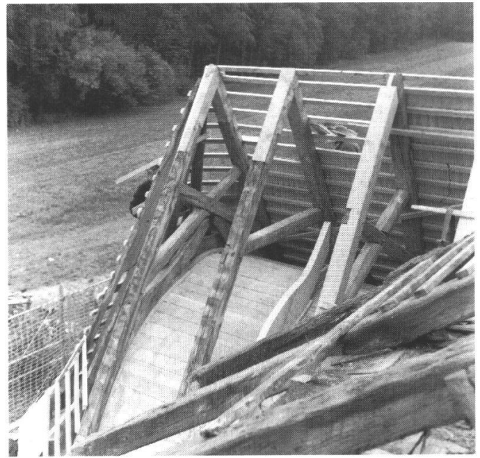
Abb. 10: Dachuntersicht des Hauptdaches mit profilierten Stichbalken.
