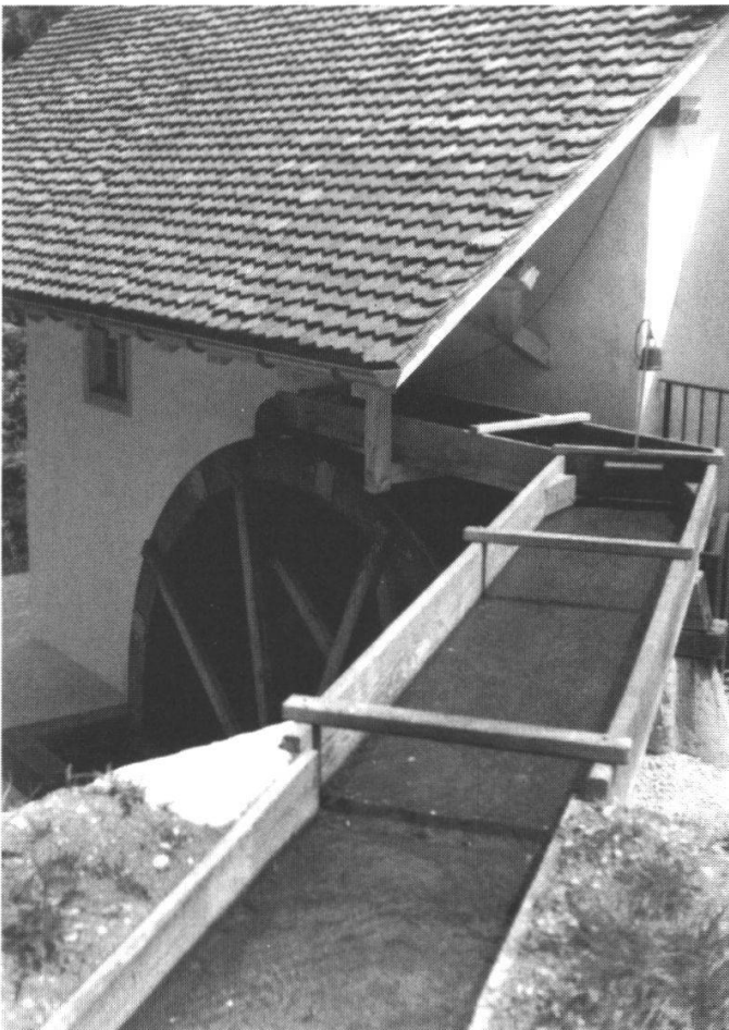
Abb. 6: Oberschlächtiges Wasserrad mit Zulaufkanal.
