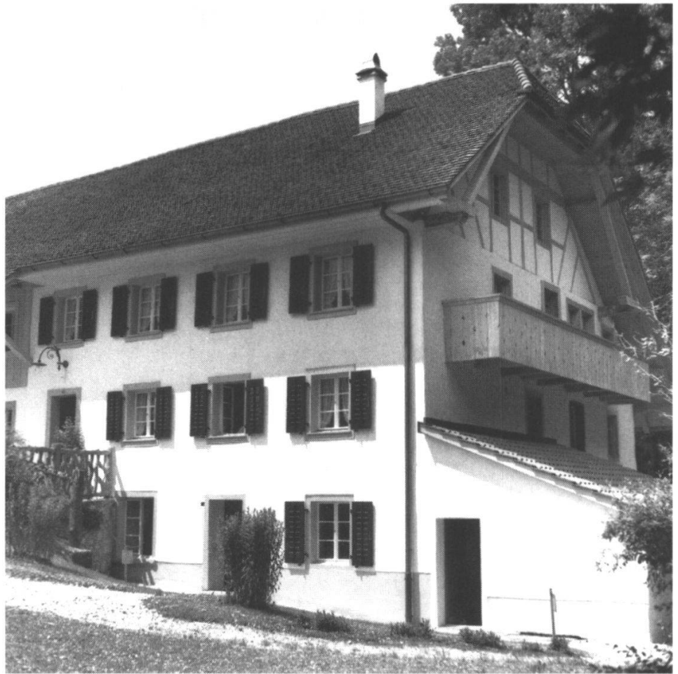
Abb. 4: Wohntrakt mit Mühleraum im Kellergeschoss.
