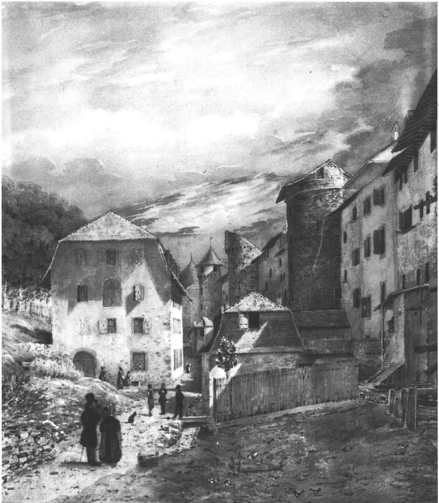
Abb. 1: Solothurn, Nordseite. Die drei mittelalterlichen Schalentürme im Burrisgraben, Zustand um 1835/40.
