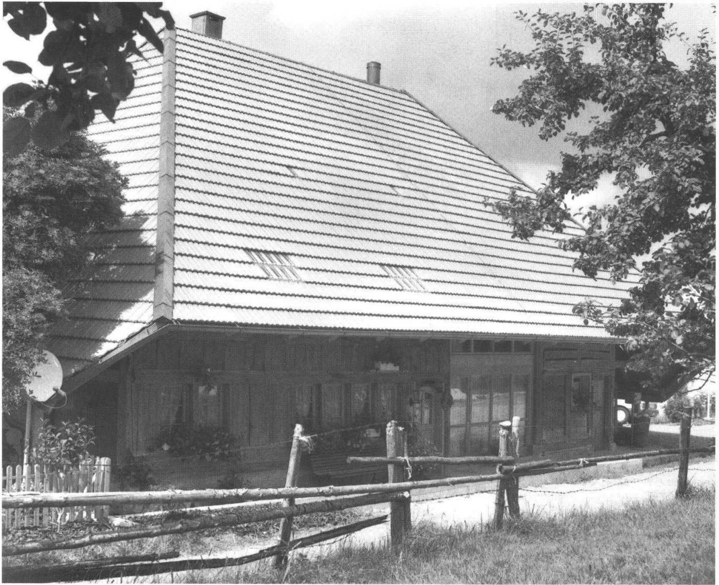
Abb. 1: Gesamtansicht des Hochstudhauses mit dem steilen, weit herunterlaufenden Walmdach.
