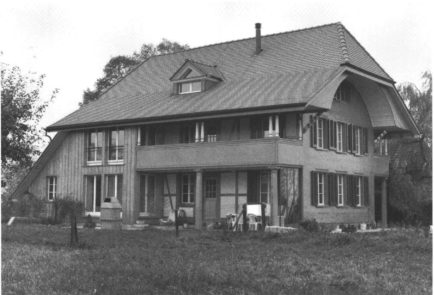
Abb. 2: ...und nach der Restaurierung.
