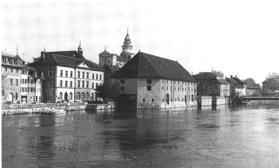
Abb. 22: Das ehemalige Kaufhaus, das spätere Schulhaus am Land. Es befindet sich links des Landhauses. Es beherbergte 1871, vom 8. Februar bis 22. März 648 Boubaki. (Foto: Markus Hochstrasser, 1980).
