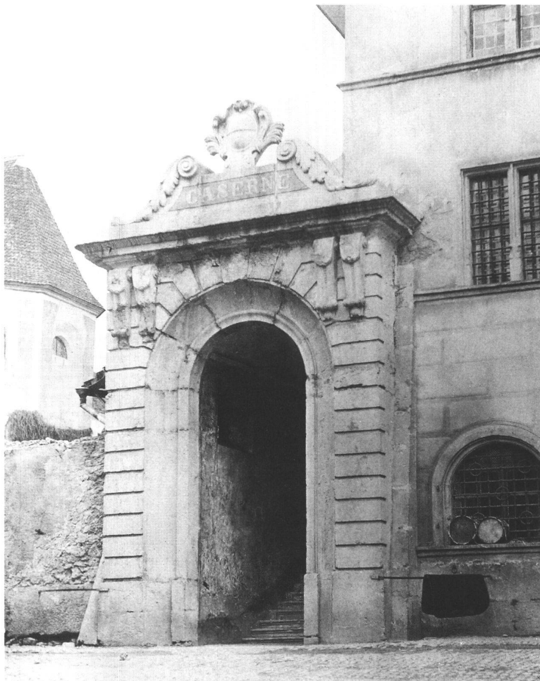
Abb. 16: Das Portal zur Caserne, 1881 abgebrochen. Foto: C. Rust, Solothurn. Repro aus «Das Bürgerhaus» Fotosammlung E. Schlatter (Denkmalpflege).
