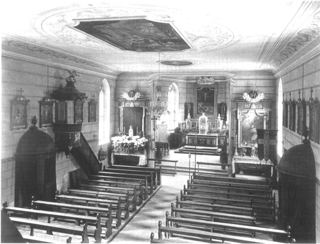
Abb. 10 Inneres der Pfarrkirche vor der Totalrenovation von 1951
