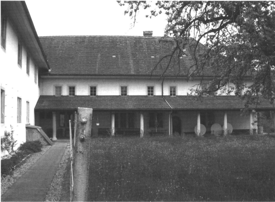
Links der Anbau von 1660 mit Kellerabgang, anschliessend der Westtrakt des Klostergevierts. Davor wurde 1914 eine offene Halle angebaut (Bild: Andreas Röder)
