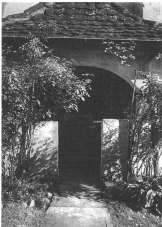
Eingang ins kleine Beinhaus an der Nordseite der Klosterkirche. Dort wurden die Totenschädel deponiert vermutlich seit Ende des 17 Jahrhunderts
