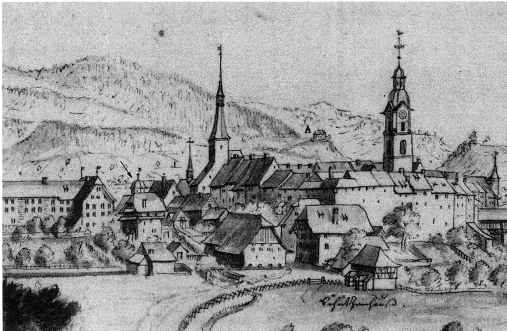
Abb. 4: Mit einiger Sicherheit ist die Oltner Heilig-Kreuz-Kapelle (Pfeil) auf Oltner Veduten nur gerade auf der Bleistiftzeichnung von Emanuel Büchel (Ausschnitt) und auf dem Stich auszumachen, den David Herrliberger nach dieser Vorlage 1756 in Kupfer gestochen hat.
