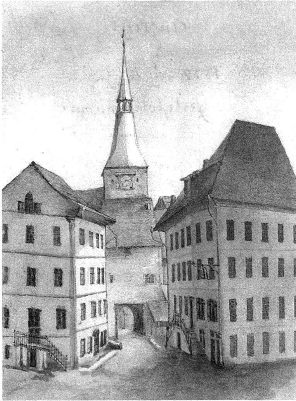
Abb. 2: Ansicht des anno 1837 abgebrochenen Oltner «Zeitglocken- turms».
