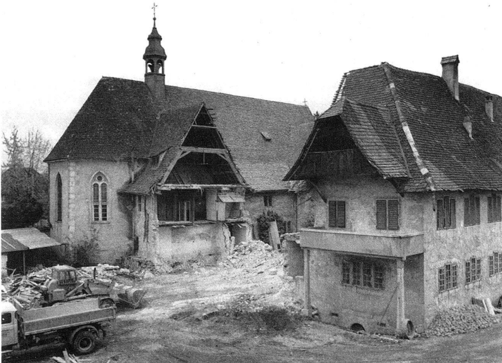
Abb. 39: Abbruch des Ostflügels. Foto: Denkmalpflege Kanton Solothurn
