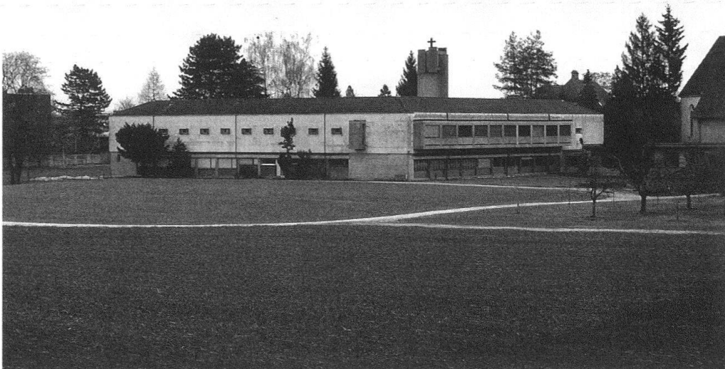
Abb. 1: Neu St. Josef Nordwestansicht; am rechten Bildrand der Chor der alten Kirche.
