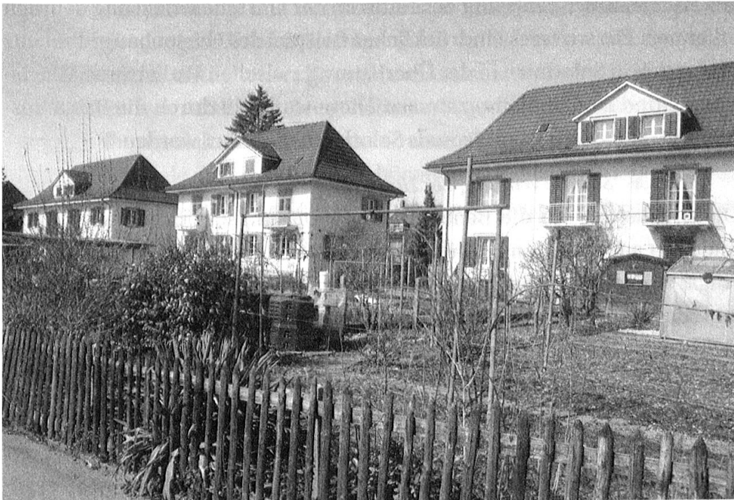
Abb. 2: Überbauung Baugenossenschaft des Verkehrspersonals Glacismatte Solothurn, 2013, Foto Autor
