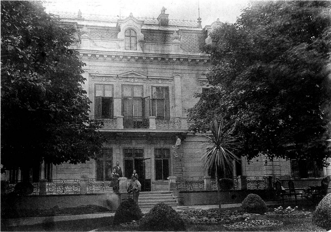
Abbildung 4: Villa von Gottfried Schenker auf der Hohen Warte 52 in Wien. Vor dem Haus Gottfried Schenker mit den Nichten Maritta (links) und Anny Schenker sowie zwei Bauarbeitern, Sommer 1888.
