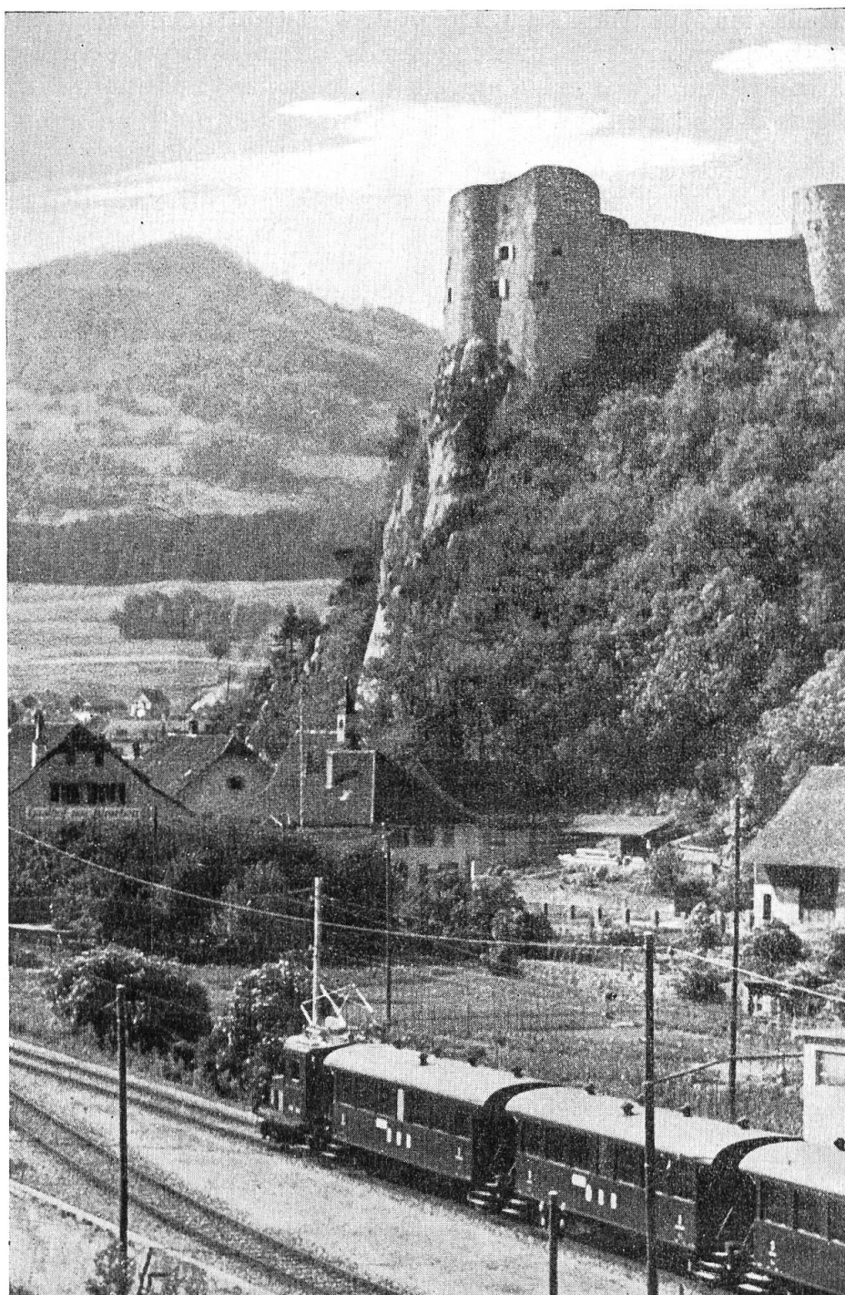
Alt-Falkenstein mit einem Zug der elektrischen Oensingen-Balsthal- Bahn.
