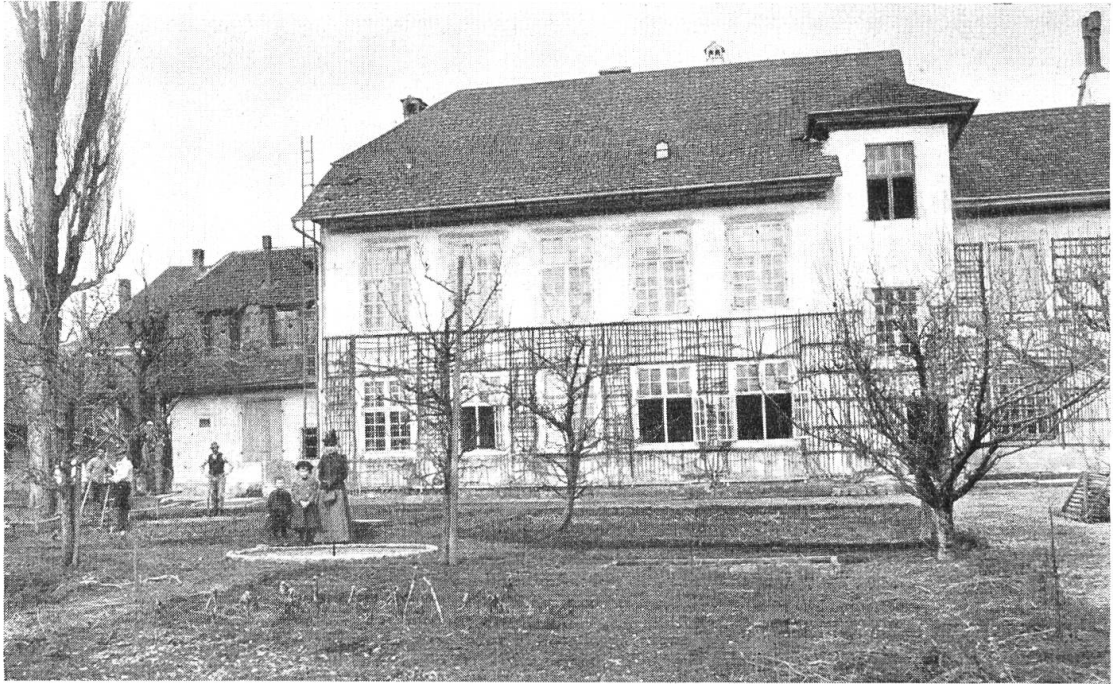
Südfront des alten «Tschanenhofes» kurz vor dem Abbruch 1899
