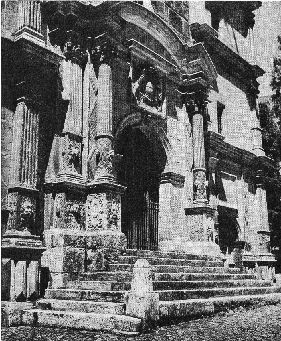
Solothurn. Die Ostfassade des Rathauses, die demnächst restauriert werden soll
