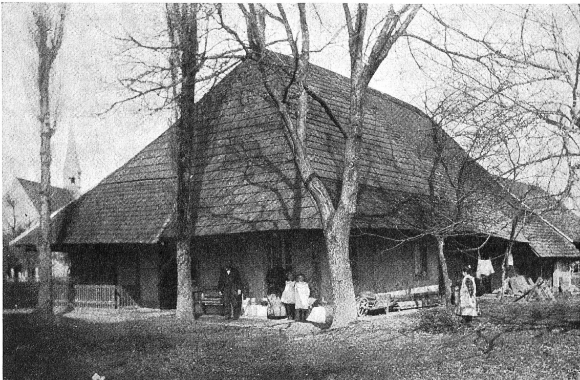
Altes Bauernhaus an der Derendingerstraße
