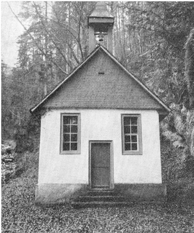
Die Horngrabenkapelle ob Matzendorf glich vor der Restaurierung eher einem verlassenen Waschlhäuschen.
