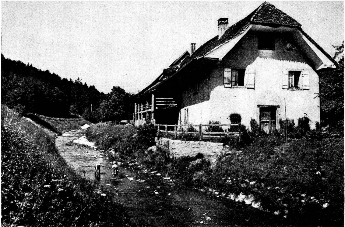
Noch steht das Gebäude des ehemaligen Hammerwerks an der Dünnern bei Matzendorf
