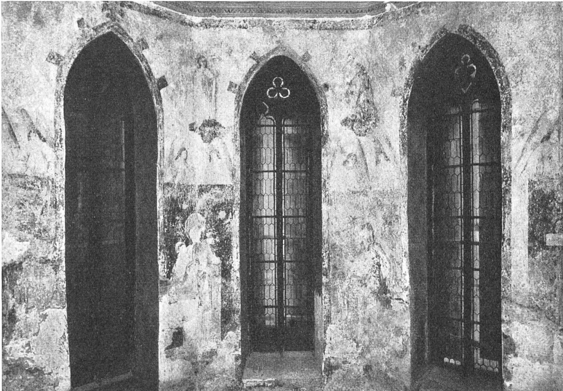
Pratteln, Kirche. Ansicht des Chorraumes mit dem deutlich erkennbaren Gesamtplan der um 1480 entstandenen Malereien. Heute zerstört
