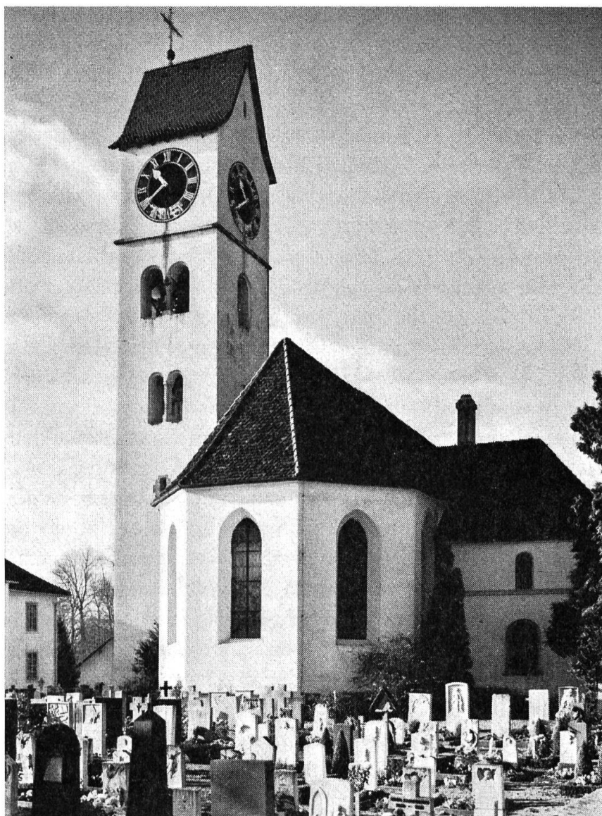
Selzach. Turm (1457) und Chor (1514) als einheitlich schöner Baukörper, von Osten aufgenommen.
