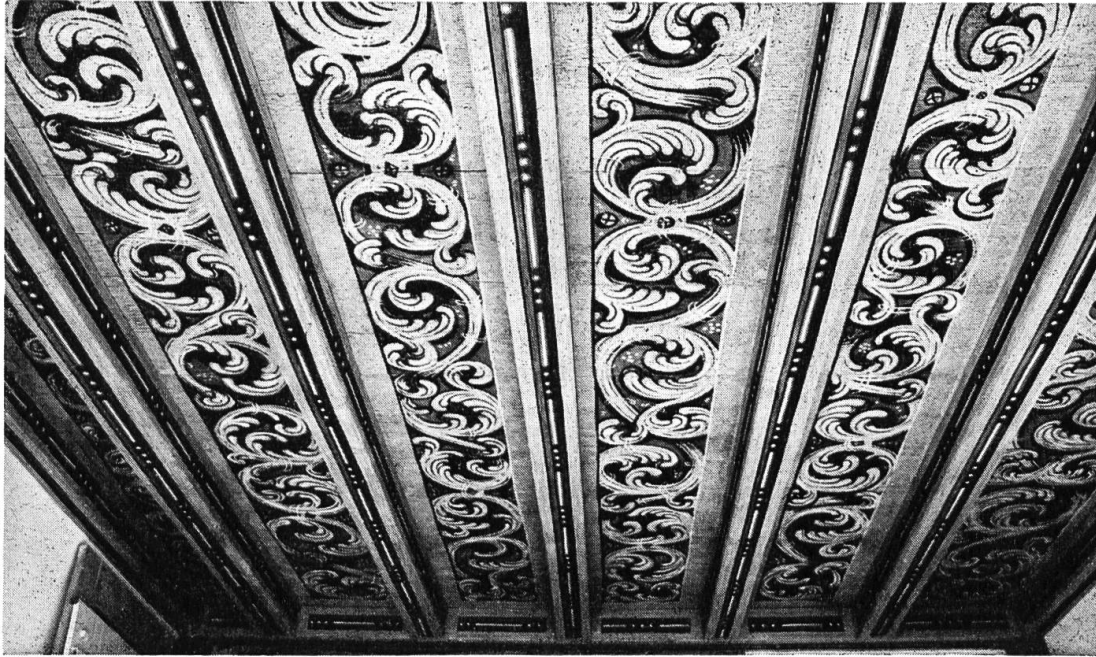
Basel, Petersgraben 24, Parterre. Neu aufgefundene barocke Balkendecke, 2. Hälfte 17. Jh. (Photo Ch. Teuwen)
