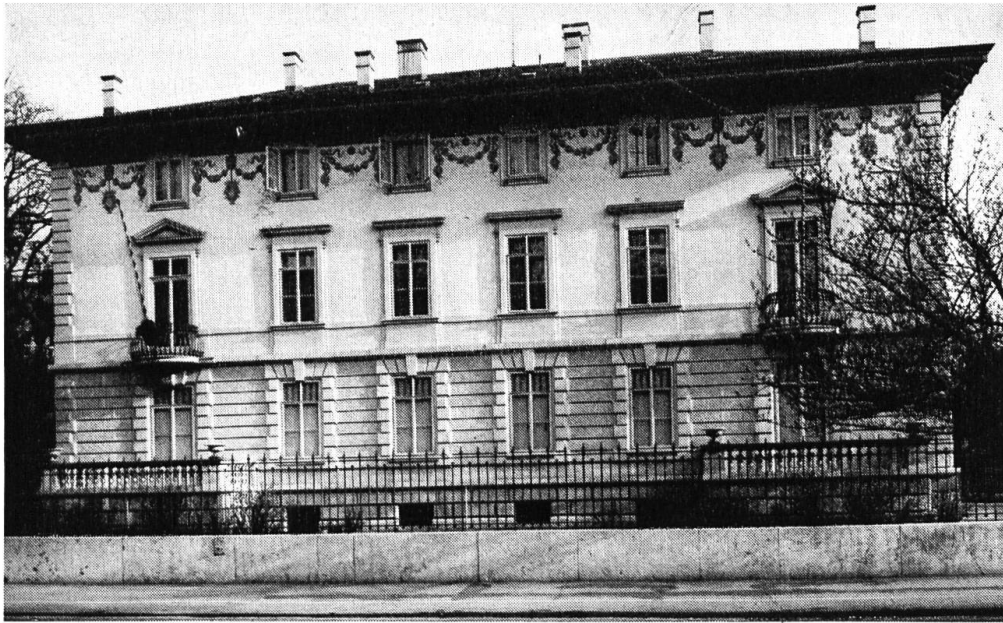
Pobé-Haus an der St.-Alban-Anlage, Abbruch bevorstehend (Foto Teuwen)
