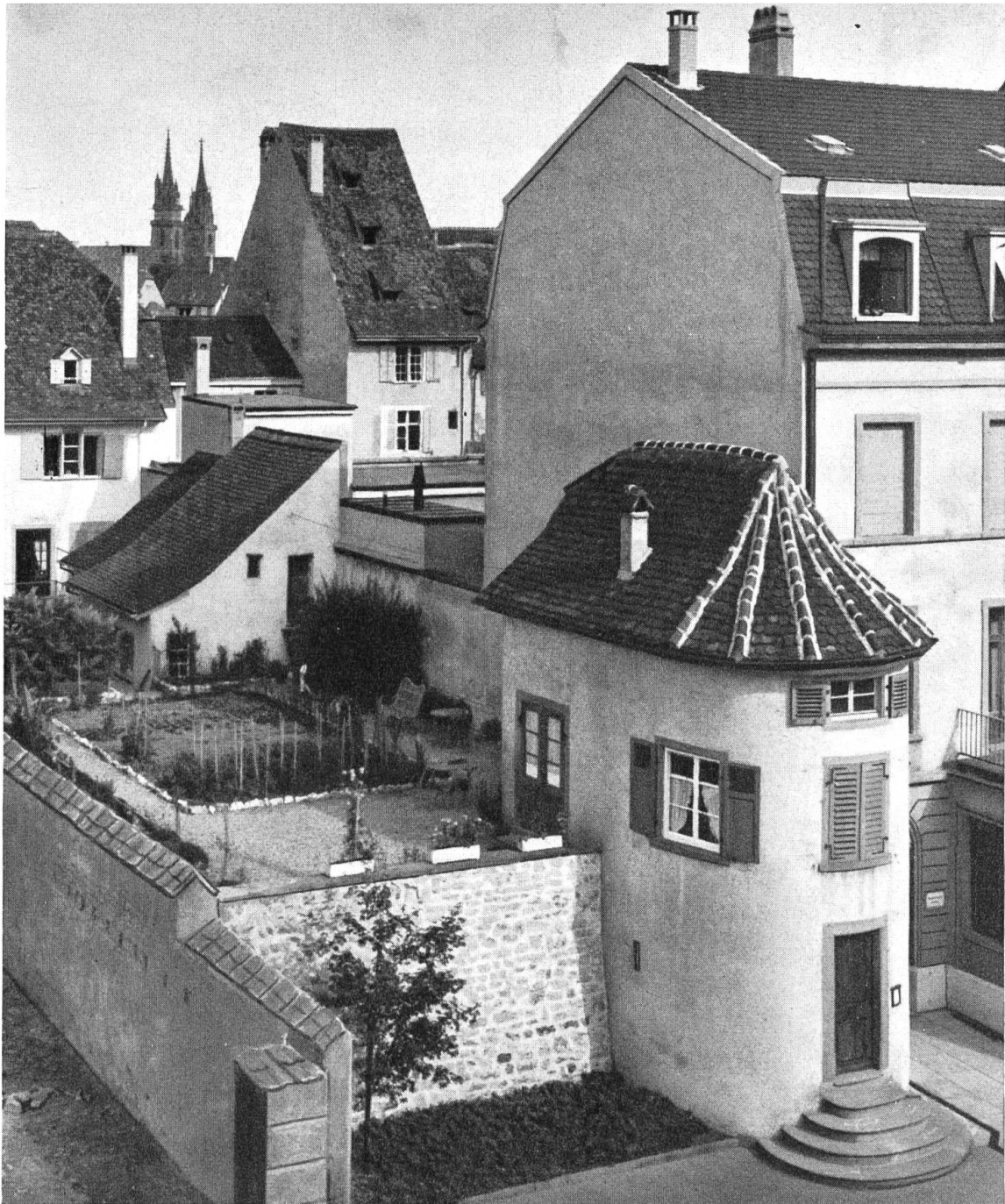
Abb. 6. Türmchen des inneren Mauerringes am «Zerkindenhof», Petersgraben 43, Mauerwerk um 1200, Ausbau barock, Ende 18. Jh. Dahinter Garten auf dem Stadtwall, hinterer Hof und hinterer Wohnbau des «Zerkindenhofes»
