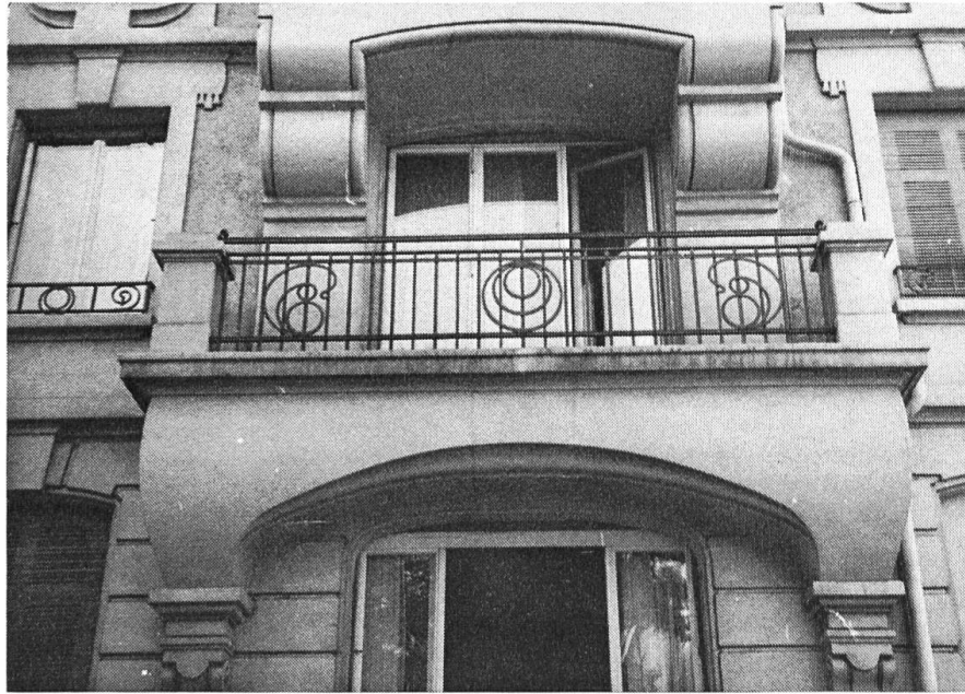
Einen temperamentvollen Jugendstil zeigt das Haus Dornacherplatz 17 von der Genfer Baufirma P. Mastella 1904/05 nach den Plänen von Hermann Reimann errichtet. Foto: O. Birkner
