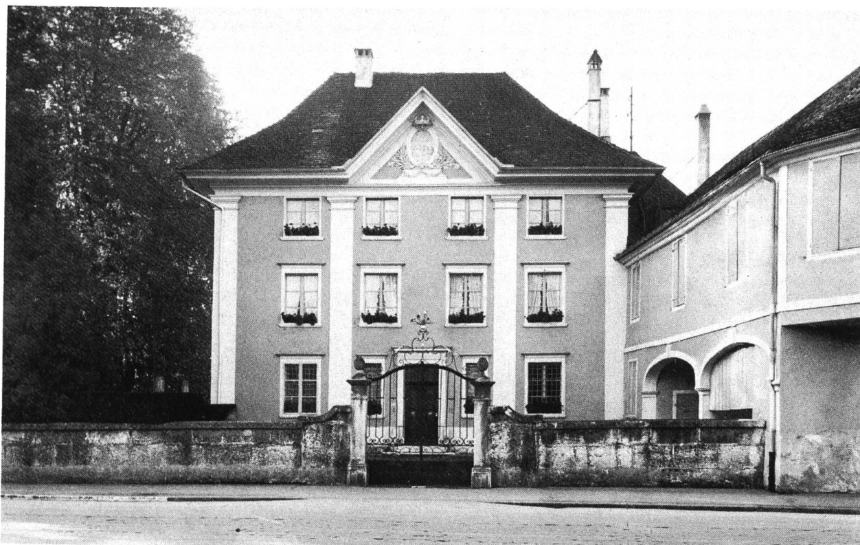
Strassenfront des Palais vor dem Neubau der Zentralbibliothek.
