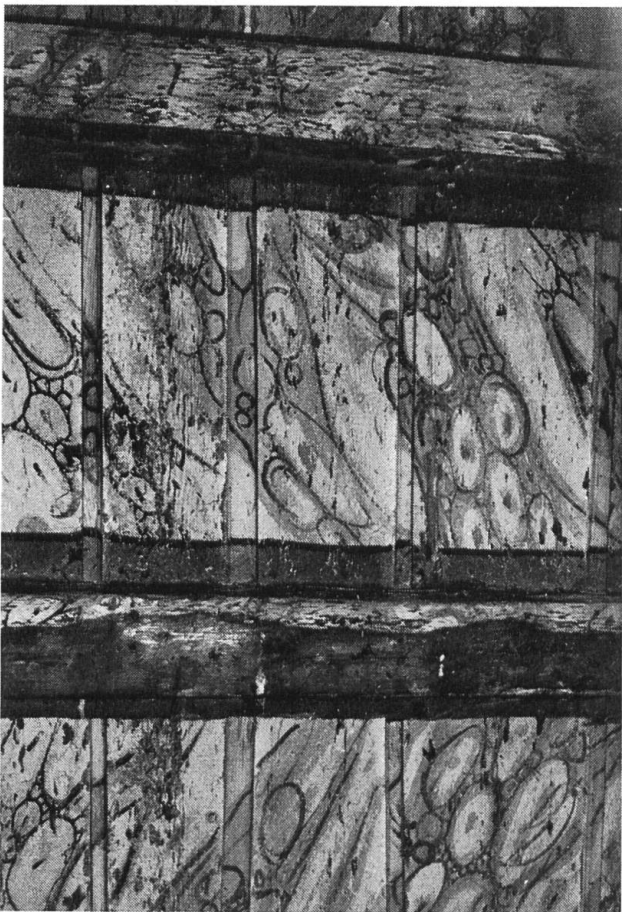
Nadelberg 30, Balkendecken. (Foto: Denkmalpflege)
