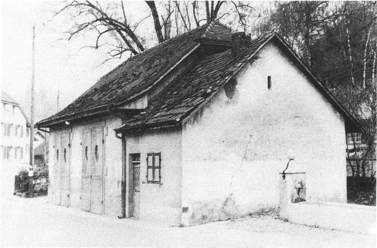
Waschhaus und Spritzenhaus im Mitteldorf, kurz vor dem Abbruch 1976.
