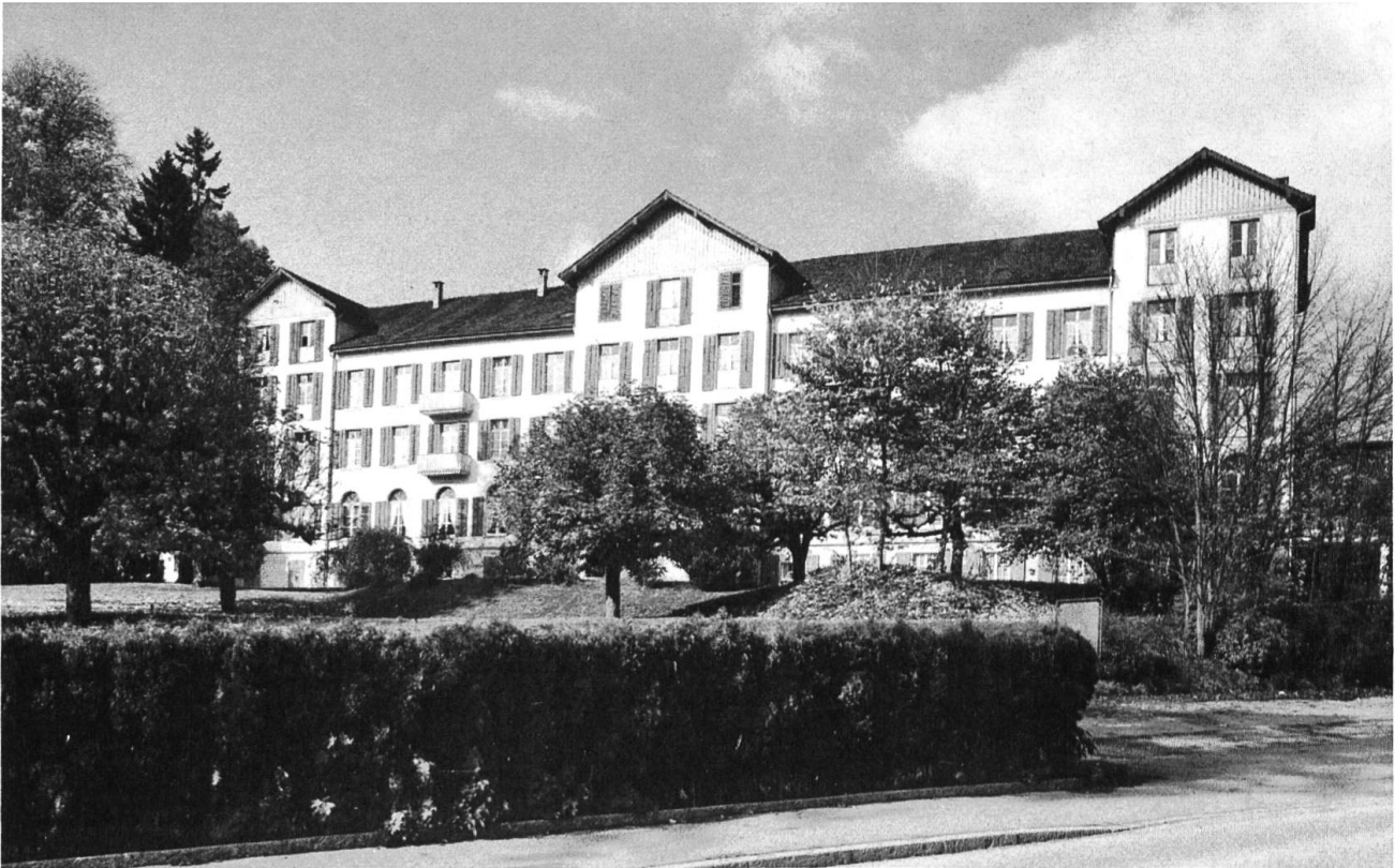
Das 1871 erbaute Kurhaus von Langenbruck mit der bereits stark veränderten Südfassade kurz vor dem Abbruch.
