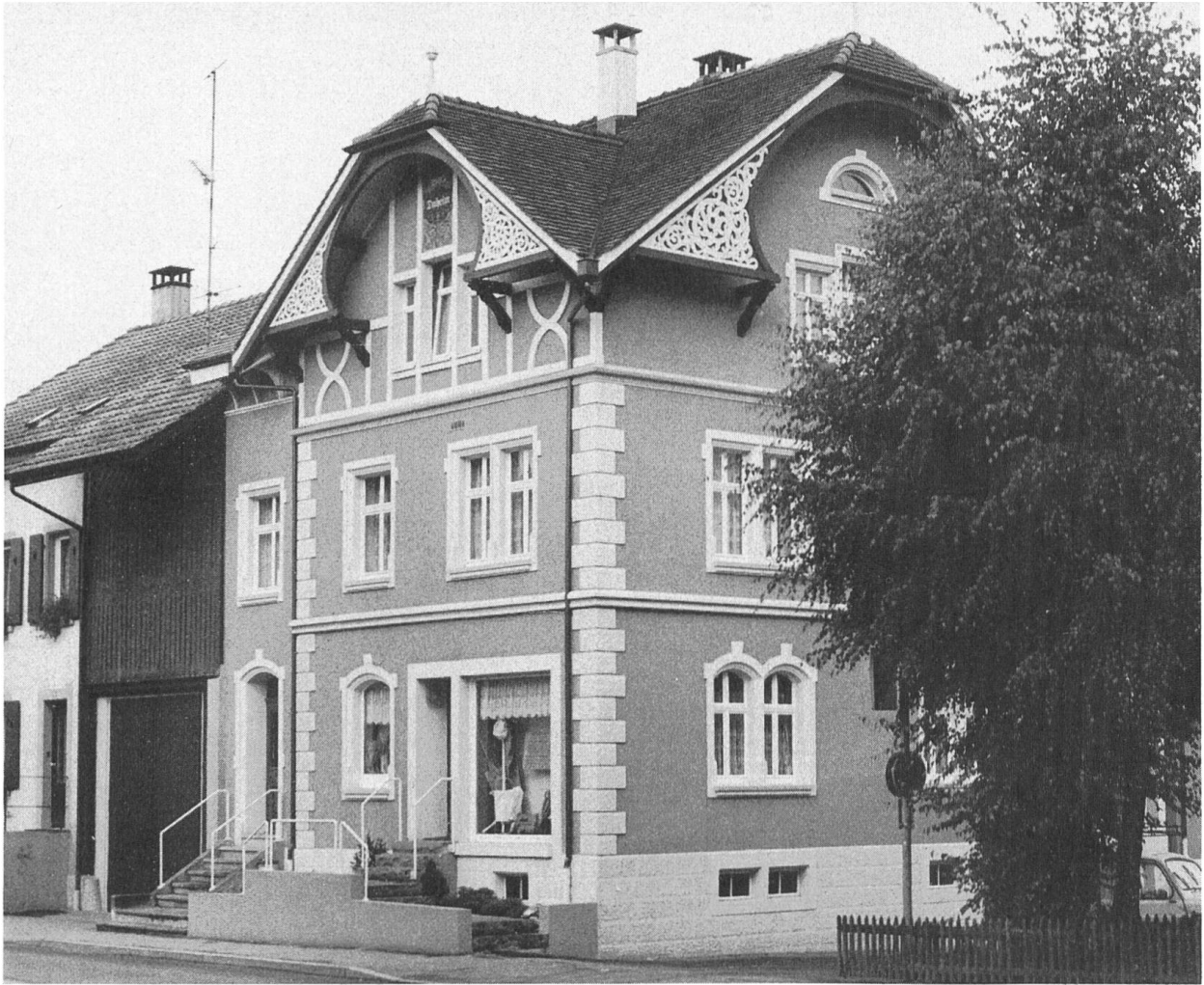
Bottmingen, Haus Therwilerstrasse 8, erbaut 1905.
