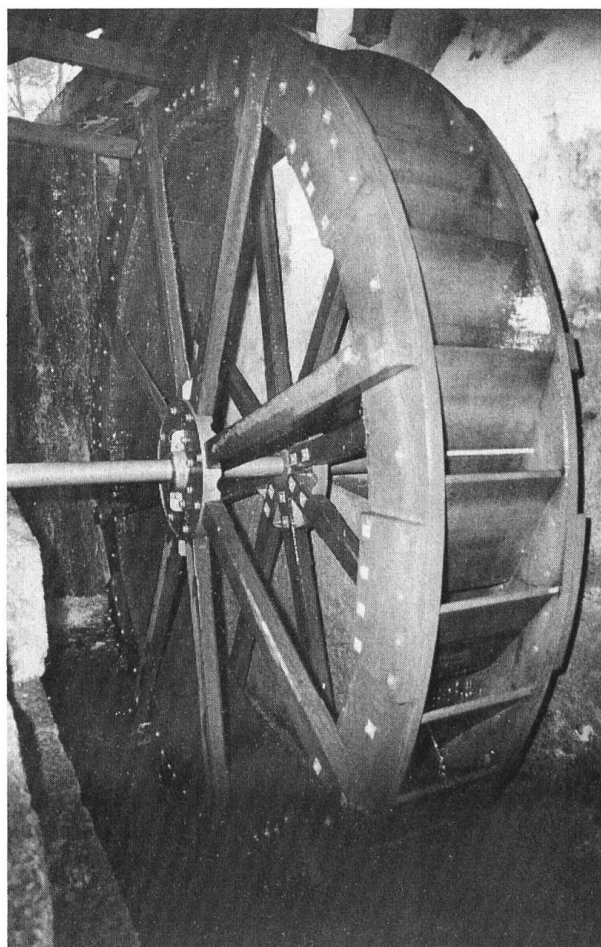
Mühle Benken, Mühlerad neu erstellt 1981/82.
