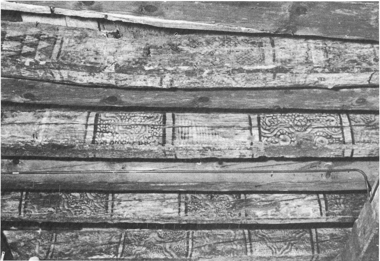
Martinsgasse 13. Saal im Keller mit bemalter Balkendecke, um 1300.
