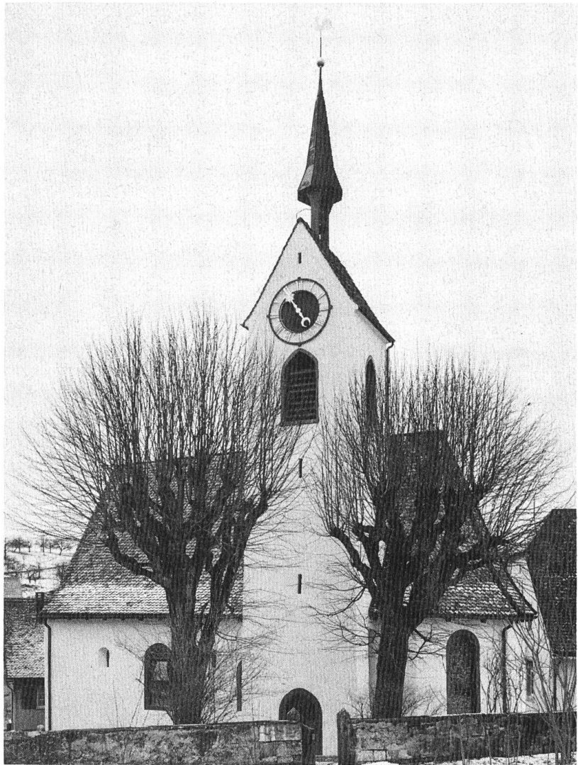
Kirche Bennwil, Blick von der Nordseite.
