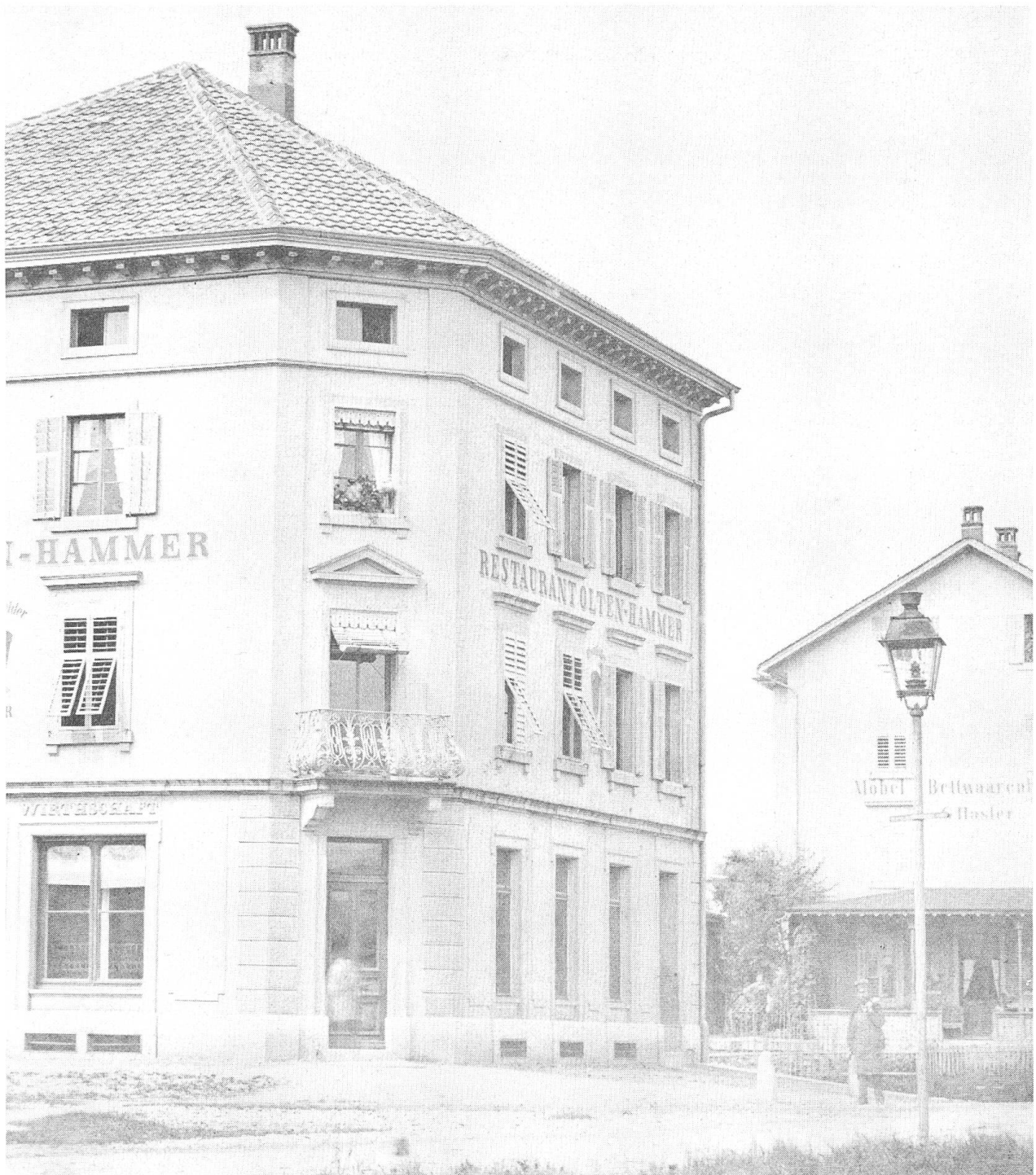
Das erste Oltner Kandelaber-Modell. Hier die 1863 beschaffte Petrollaterne beim ehem. Restaurant Olten-Hammer.
