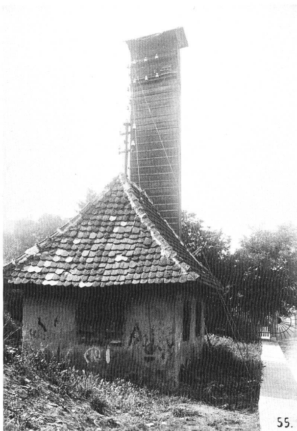
Einen Eindruck von der Pionierzeit der Elektrotechnik vermittelt diese Transformatorstation beim Hotel Schweizerhof 1918.
