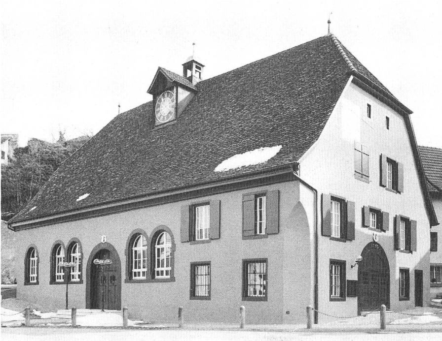
Münchenstein. Trotte. Erbaut 1560, umgebaut anfangs 19. Jahrhundert. Aussenrestaurierung mit neuer Vorplatzgestaltung 1985.
