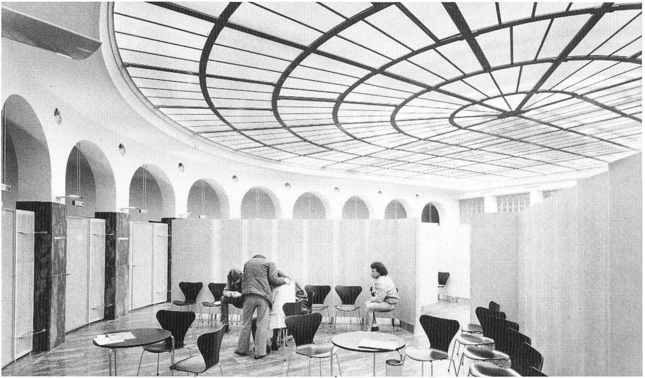
Das Arbeitsamt, Utengasse 36, erbaut 1931 von Erwin Heman. Oben: Halle nach der Umgestaltung durch die Architekten Fierz & Bader.
