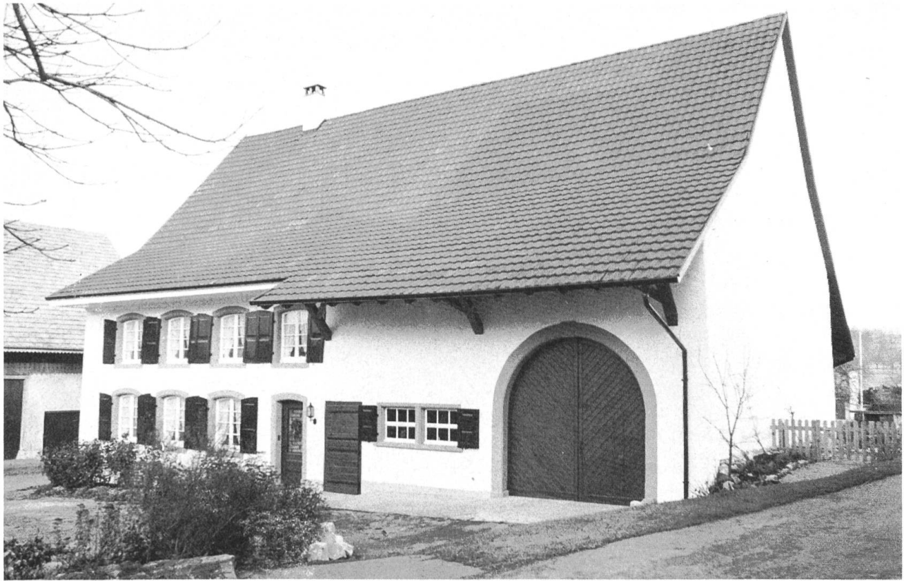
Rünenberg. Ehemaliges Bauernhaus und Post, Hauptstrasse 6.
