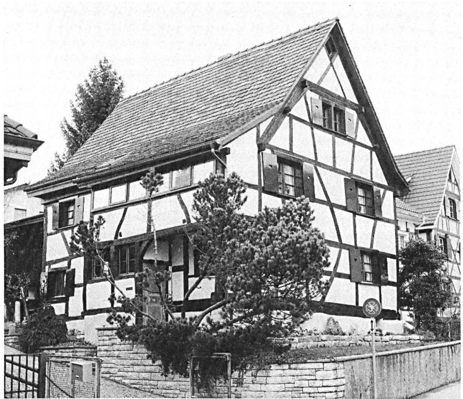
Fachwerkhaus Schönenbuchstrasse 9 in Allschwil.
